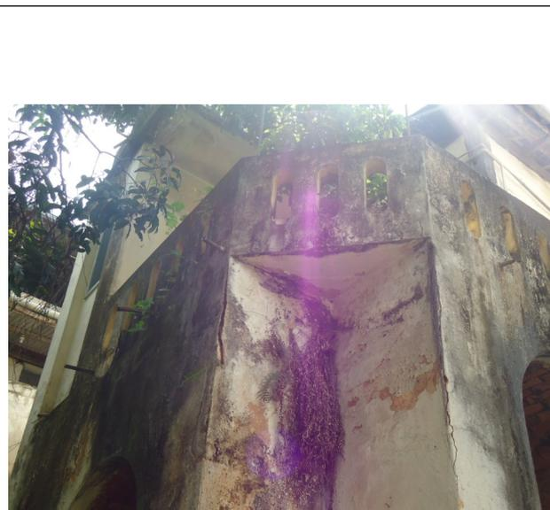
Figuras 12 e 13 – Detalhes das sujidades e umidade nas alvenarias, 2016. Fonte: CPPC
