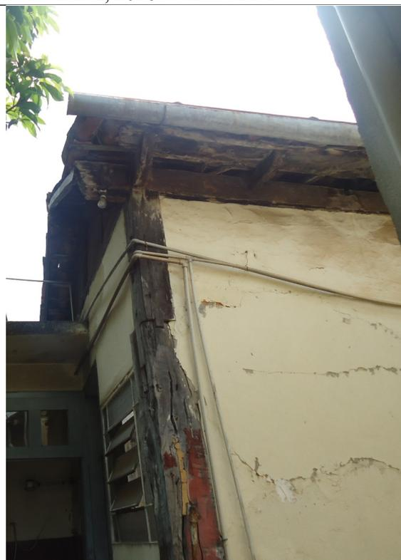
Figura 15 – Danos nos elementos estruturais de madeira.
