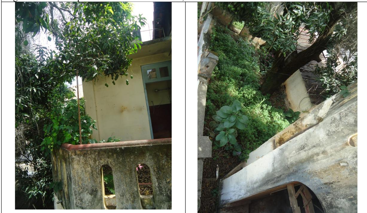
Figuras 10 e 11 – Detalhe da vegetação invasiva de pequeno e grande porte e das manchas de umidade nas alvenarias na parte posterior da edificação.
