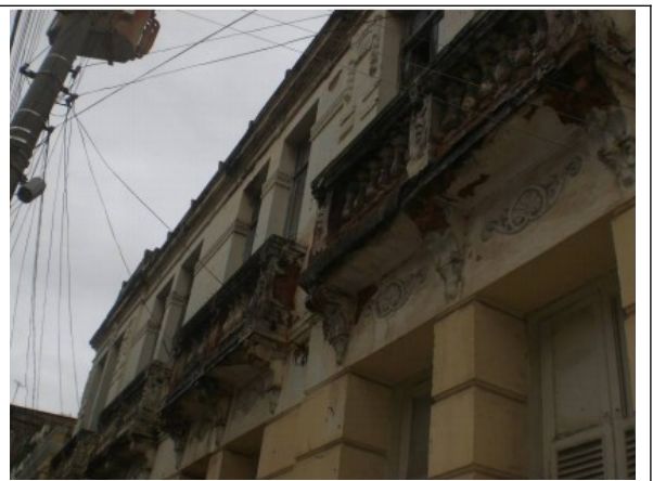
Figura 07 – Imagem da edificação com detalhe da fachada, 2011. Fonte: Ficha de Inventário.
