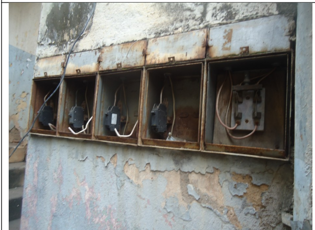
Figuras 13 e 14 – Instalações elétricas precárias.
