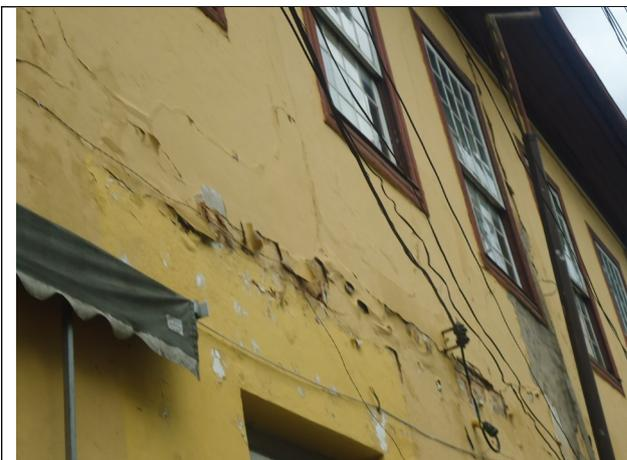
Figura 13 – Fiação aparente, danos nas alvenarias.
