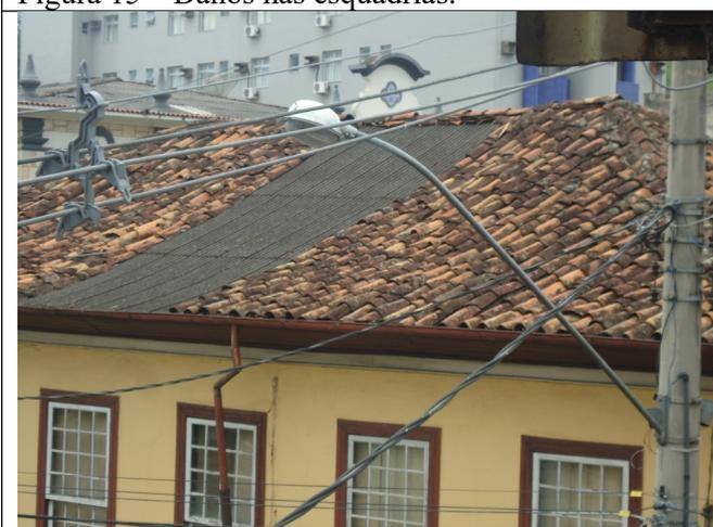
Figura 17 – Descaracterização da cobertura.
