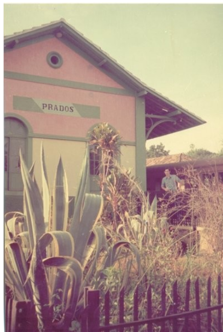
Figura 02- Estação Ferroviária de Prados. Fonte: https://www.pradosmg.com.br/estacao-prados
