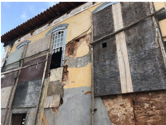
Figura 06 - Trechos das alvenarias protegidos por tapumes.
