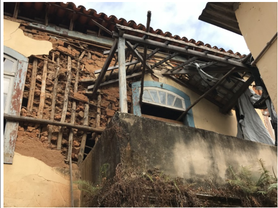
Figura 03 - Desprendimento do enchimento do pau a pique.
