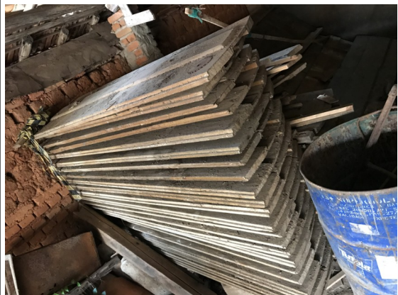
Figura 07 - Esquadrias originais armazenadas de forma provisória no local.
