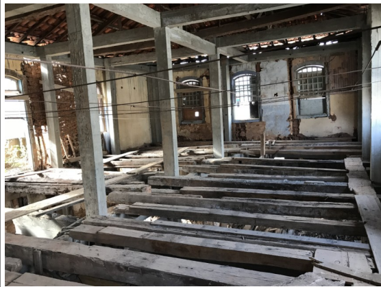
Figura 12 - Aspecto interno do imóvel onde nota-se a execução de estrutura em concreto armado e a existência de madeira original no interior da edificação.
