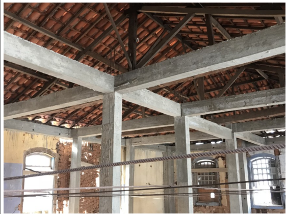
Figura 11 - Aspecto interno do imóvel onde nota-se a execução de estrutura em concreto armado.
