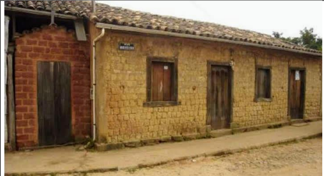
Figura 02 – Fachada original do imóvel.
