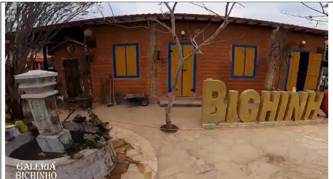
Figura 07 – Edificação após reconstrução.
