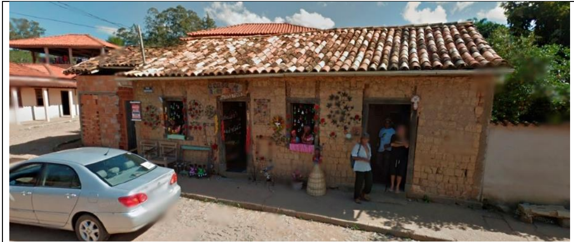
Figura 04 – Imóvel situado à Rua Moisés Pinto de Sousa, nº 05, povoado de Vitoriano Veloso (Bichinho), antes do início das obras de intervenção. Fonte: Google Street View, 2012.
