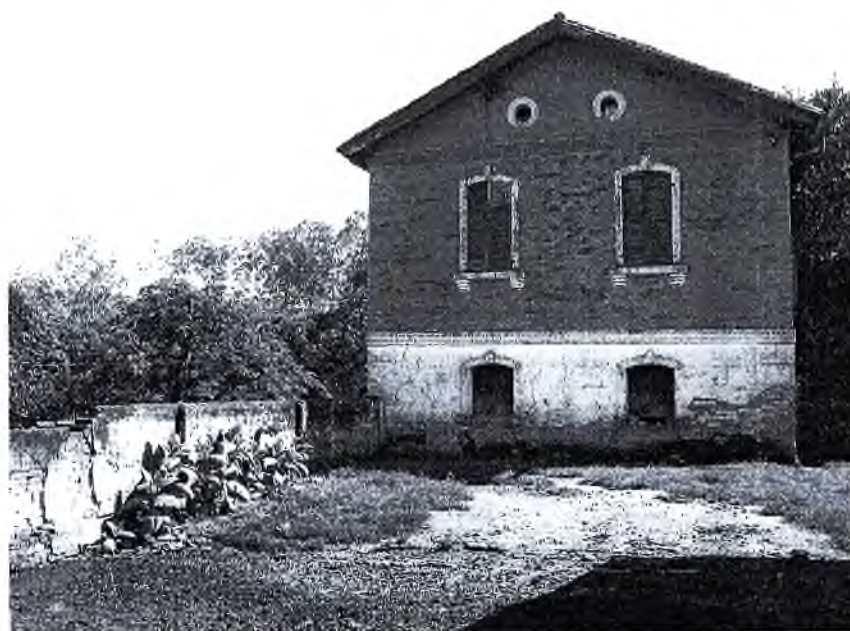
Foto 02: Município de Goianá - MG. Fazenda da Fortaleza de Sant'Anna. Casa do administrador e hospital para os escravo: vista do curral. Fotógrafo: Elza Vieira. Data: 16/02/2009.
