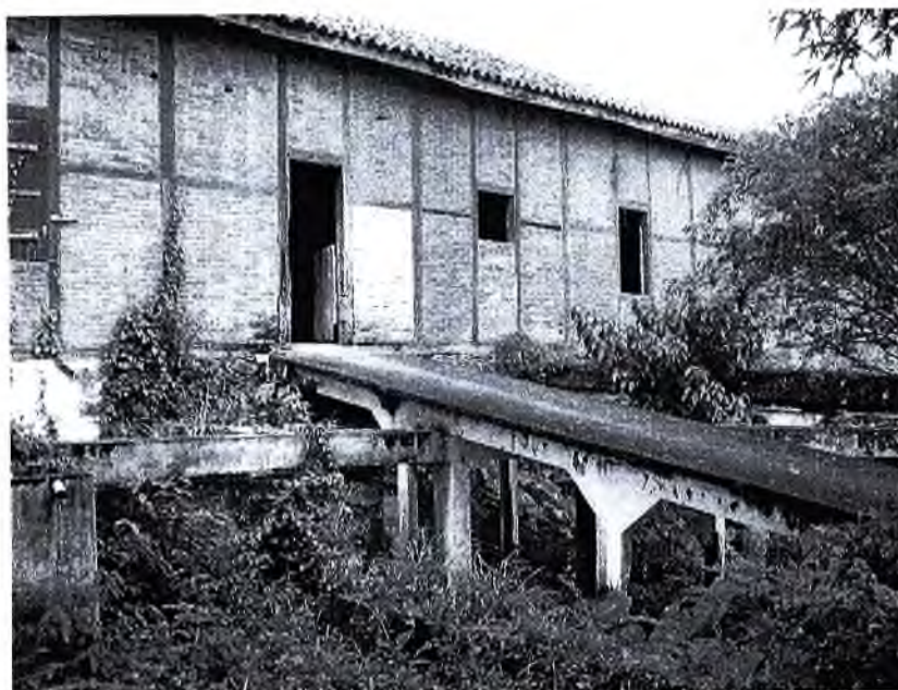
Foto 04: Município de Goianá - MG. Fazenda Fortaleza de Sant'Anna. Vista posterior das tulhas de café: detalhe do sistema de canais para o transporte do café. Fotógrafo: Elza Vieira. Data: 16/02/2009.
