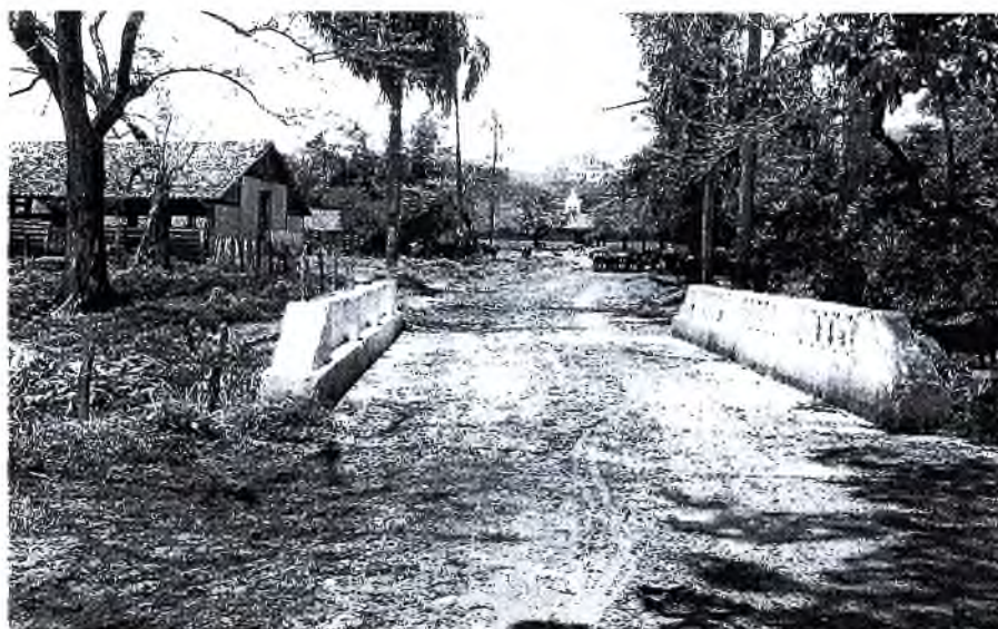
Foto 01: Município de Goianá - MG. Fazenda da Fortaleza de Sant'Anna. Situação e ambiência: vista do pontilhão. Fotógrafo: Elza Vieira. Data: 16/02/2009.
