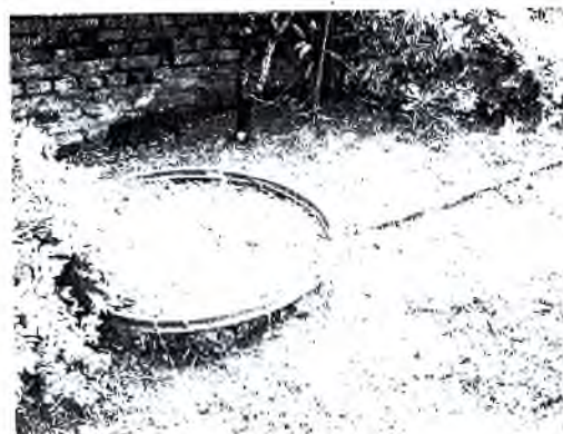
Foto 04: Município de Goianá - MG. Fazenda da Fortaleza de Sant'Anna. Terreiro de café: detalhe do sistema de trilhos das vagonetas. Fotógrafo: Elza Vieira. Data: 16/02/2009.
