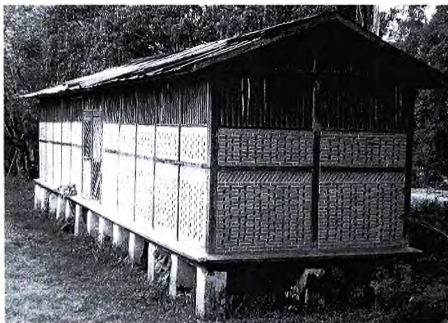
Foto 01: Município de Goianá - MG. Fazenda da Fortaleza de Sant'Anna. Paiol: vista da fachada frontal e lateral direita. Fotógrafo: Elza Vieira. Data: 16/02/2009.
