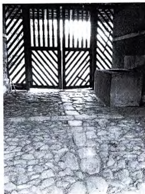
Foto 04: Município de Goianá - MG. Fazenda da Fortaleza de Sant'Anna. Estábulo e casa das charretes: piso em pedra no interior do estábulo. Fotógrafo: Elza Vieira. Data: 16/02/2009.
