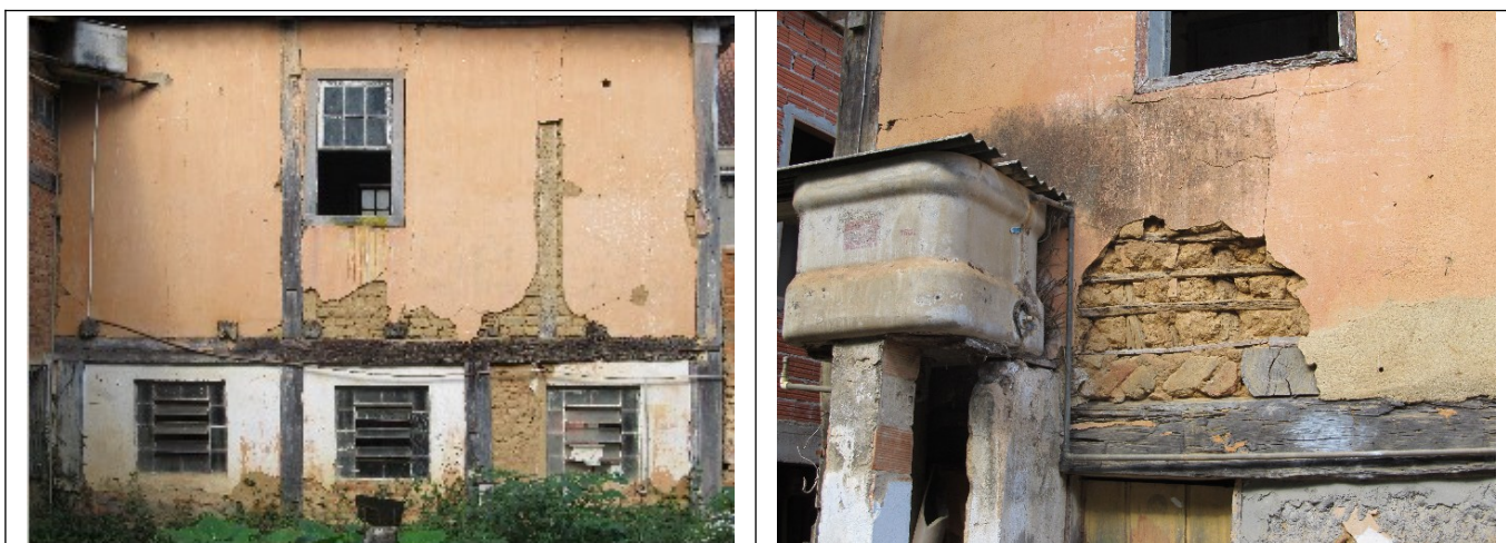
Figura 12 e 13 – Imagens dos fundos do prédio da antiga Prefeitura de Presidente Bernardes. Fotos da vistoria realizada em 28/06/2012.
