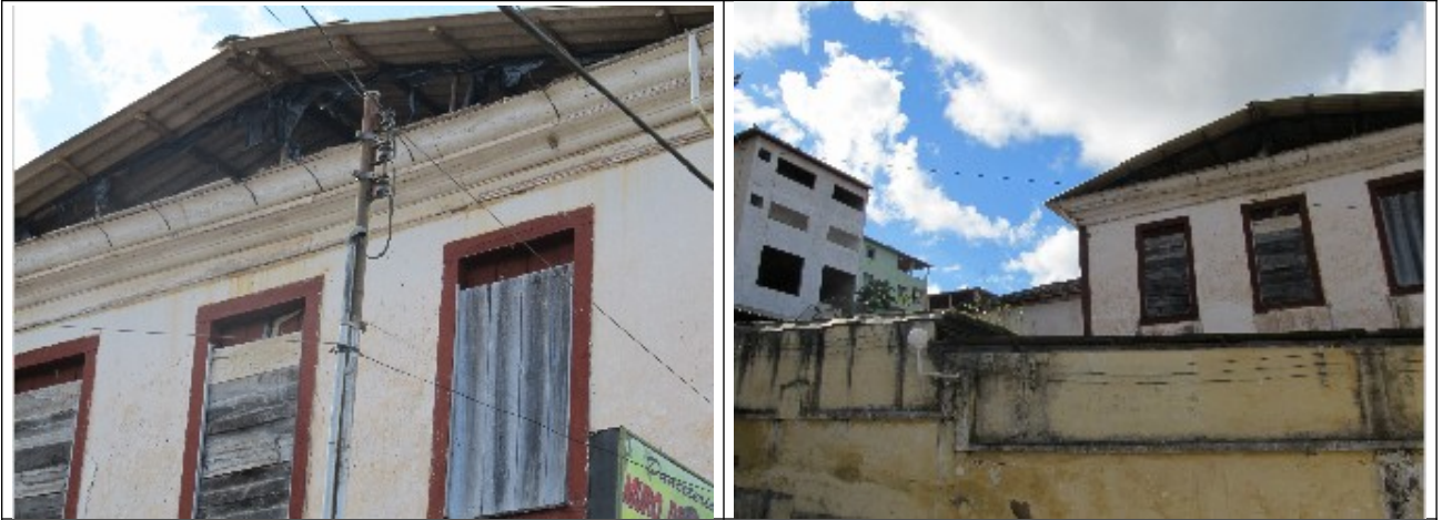
Figura 14 e 15- Imagens externas do casarão de João Soares Vidigal, destacando detalhe do telhado e nova construção nos fundos. Fotos da vistoria realizada em 28/06/2012.
