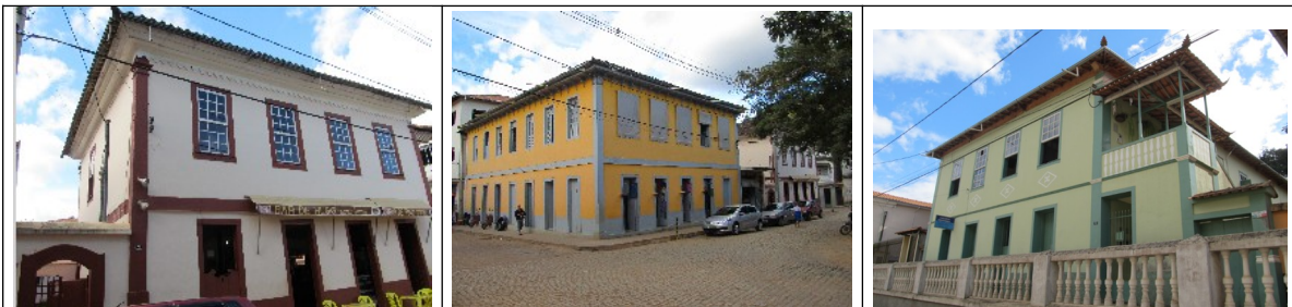
Figura 10, 11 e 12- Casarões de Maria Aparecida Quintão, Luiz Quintão Vidigal e Tadeu Guimarães, todos na Praça Cônego Lopes, nº 27, 06 e 03, respectivamente. Fotos da vistoria realizada em 28/06/2012.
