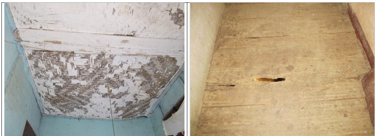
Figura 20 e 21- Imagens internas do casarão de João Soares Vidigal, destacando trecho de seu forro e de seu assoalho. Fotos da vistoria realizada em 28/06/2012.
