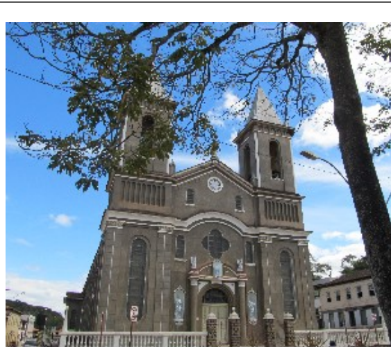
Figura 05- Igreja Matriz de Santo Antônio em Presidente Bernardes. Foto da vistoria realizada em 28/16/2012.
