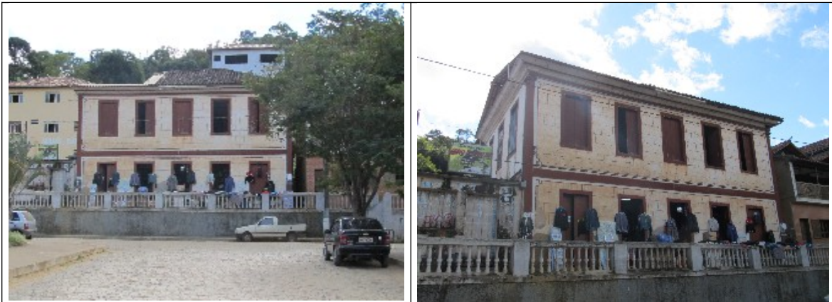
Figura 08 e 09- Imagens externas do casarão de João Soares Vidigal. Fotos da vistoria realizada em 28/06/2012
