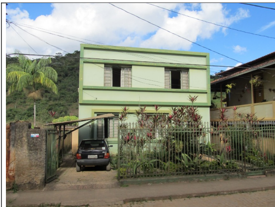
Figura 24 – Imóvel localizado na Praça Cônego Lopes.
