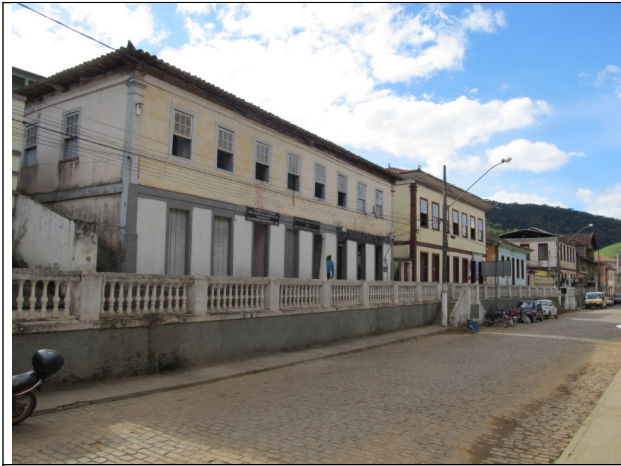
Figura 26 – Conjunto das edificações.
