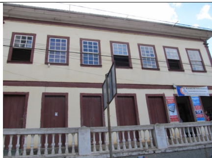
Figura 15 – Imóvel localizado na Praça Cônego Lopes nº 11
