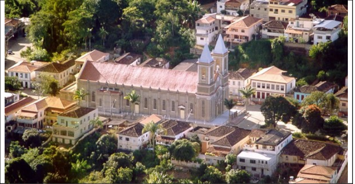
Figura 06 – Vista aérea com destaque da igreja.
