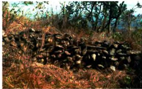
Foto 59 - Tanque - Detalhe de arrimo
