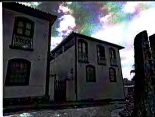
Anexo à Edificação Principal
