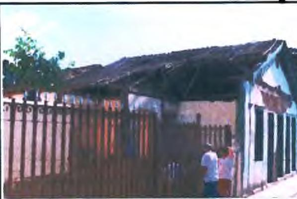
66: Vista da fachada lateral direita; telhado danificado, o que favorece a entrada da umidade, bem como acelera o processo destrutivo.
