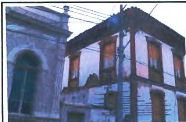
Foto 5: Deslocamento do reboco causado pelas intempéries, por meio da ação conjunta da umidade e variação de temperatura.
