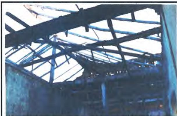
Foto 21: Detalhe da estrutura do telhado, o qual se encontra em estágio avançado de decomposição, com risco de desabamento.
