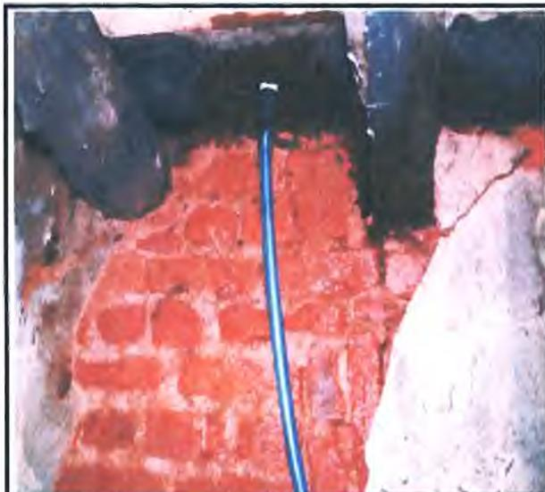
Foto 43: Local onde há vazamento de água (no porão) proveniente do salão de beleza no 1º pavimento.
