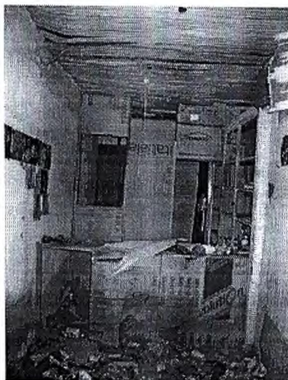
Foto 9 – Forro em madeira deteriorado e entulho em cômodo
