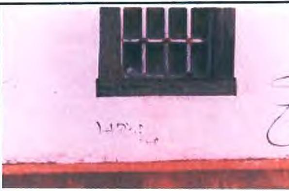
Foto 54: Detalhe para o apodrecimento da madeira da janela, na lateral direita da edificação, bem como dos vidros dos caixilhos quebrados.
