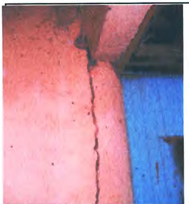
Foto 20: Rachadura vertical no final do corredor, à esquerda, mostrado na foto 18.
