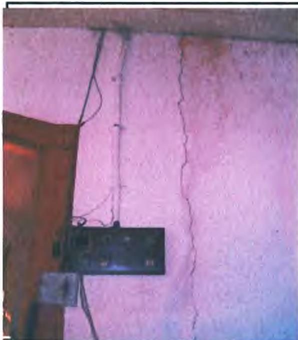
Foto 35: Detalhe da fiação elétrica irregular sem utilização de eletrodutos, aumentando-se o risco de incêndio, bem como manchas causadas pela umidade e trinca vertical na parede.
