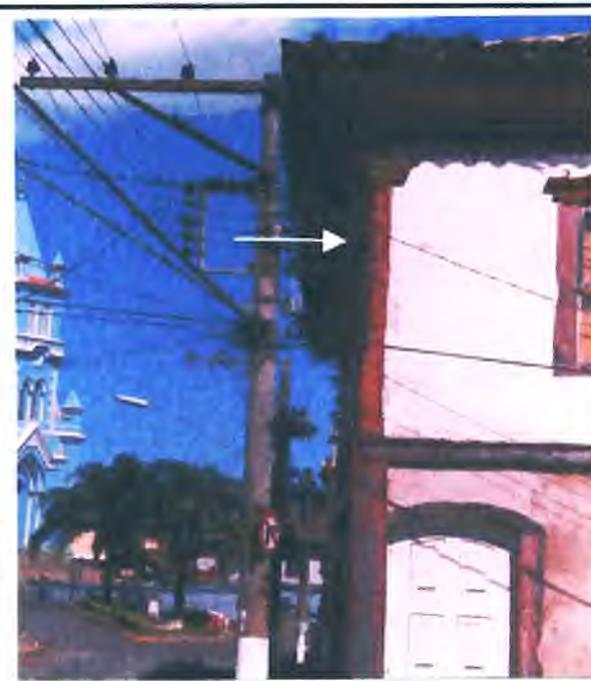
Foto 4: Detalhe para o tombamento da estrutura, tornando-a mais fragilizada.
