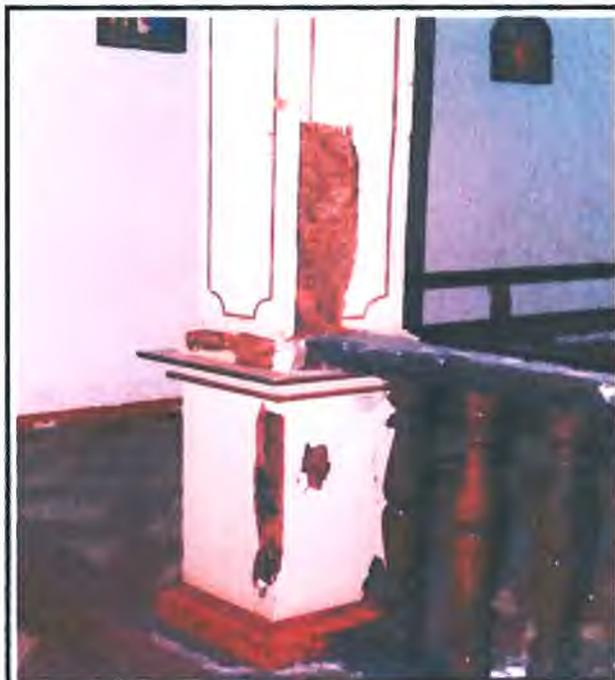
Foto 37: Coluna de madeira de sustentação da nave atacada por cupins.
