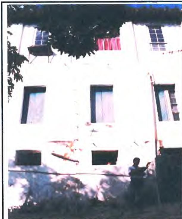
Foto 47: Manchas de umidade na parede dos fundos, bem como descolamento da pintura.
