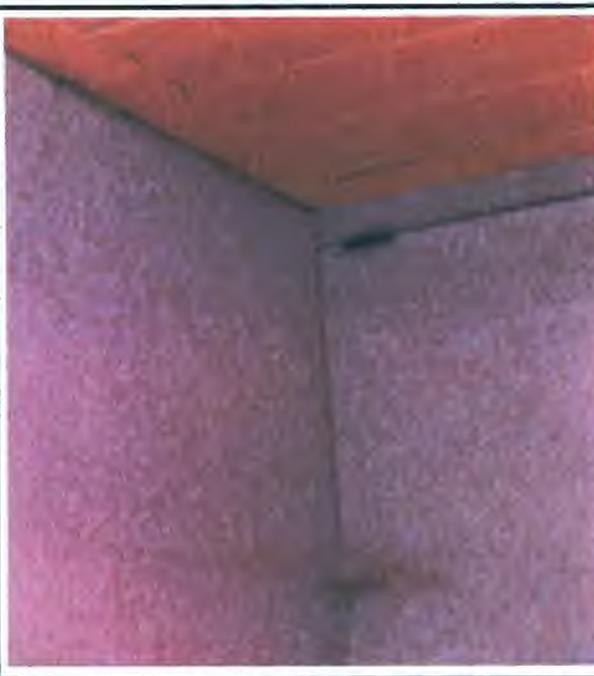
Foto 42: Rachadura no alto da parede da cozinha.
