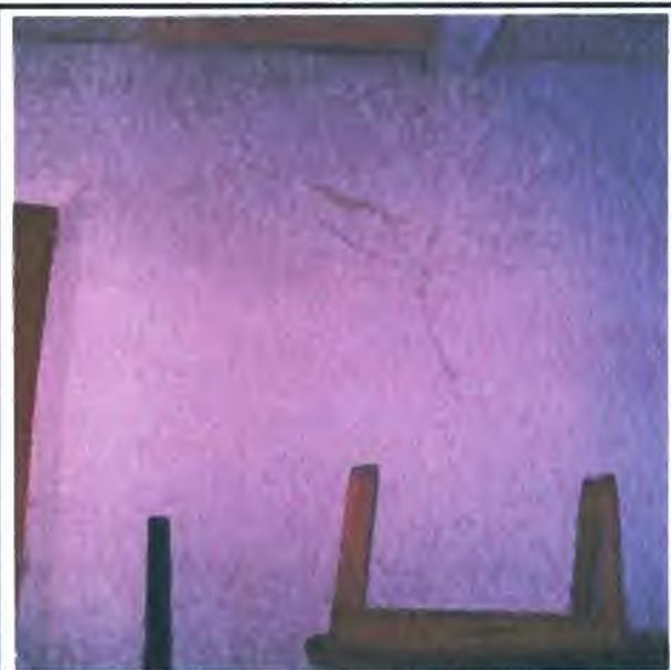
Foto 34: Fissuras na parede com início de descolamento da pintura.
