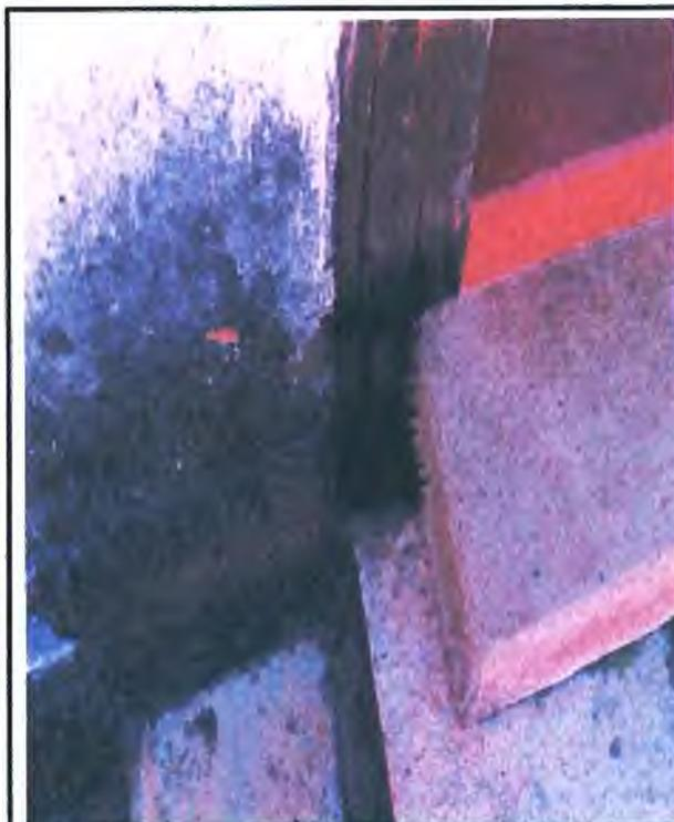
Foto 31: Abertura, próxima à porta lateral direita, que favorece a entrada das águas pluviais, bem como o apodrecimento da madeira.
