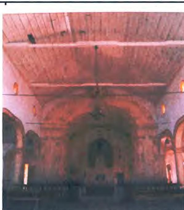
Foto 36: Vista do forro da nave e do altar-mor; foram encontradas fezes de pombos em grande parte da igreja, especialmente no Oratório, deteriorando o madeiramento.
