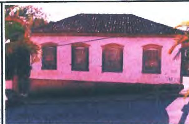
Foto 50: Vista da fachada principal; os vidros dos caixilhos das janelas estão quebrados, bem como há a presença de sujidades na pintura.
