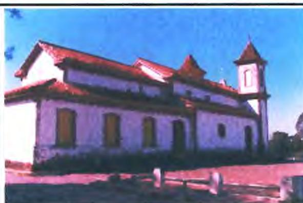
Foto 26: Fachada lateral direita apresentando manchas escuras devido à umidade, bem como descolamento da pintura em alguns pontos.
