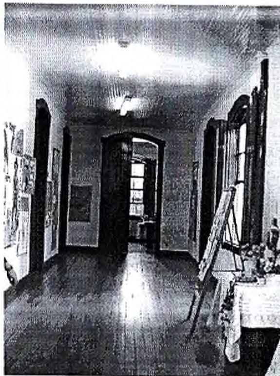
Foto 6 – Circulação interna do 1º pavimento: piso em tabuado estreito de madeira produto de substituição
