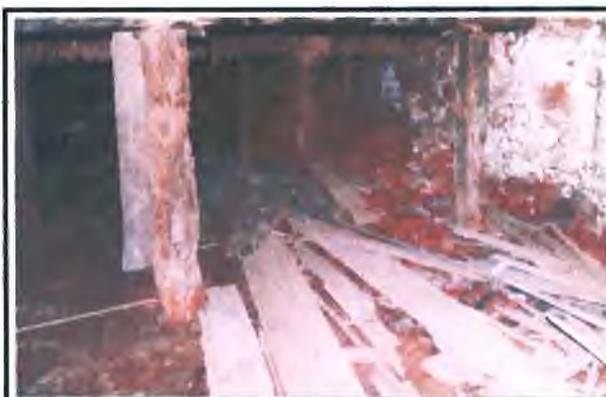
Foto 45: Os esteios estão apoiados em solo úmido, o que favorece o apodrecimento da madeira pela proliferação de fungos e outros agressores na interface solo-ar.
