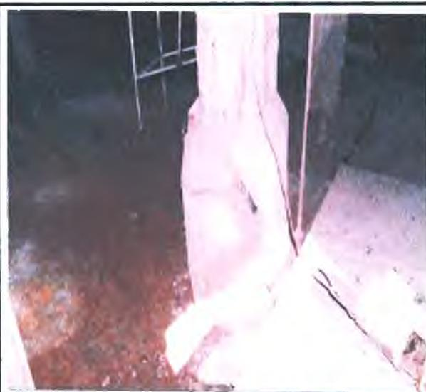
Foto 44: Coluna de sustentação trincada e com flambagem; a umidade excessiva local favorece o apodrecimento dos esteios de madeira.
