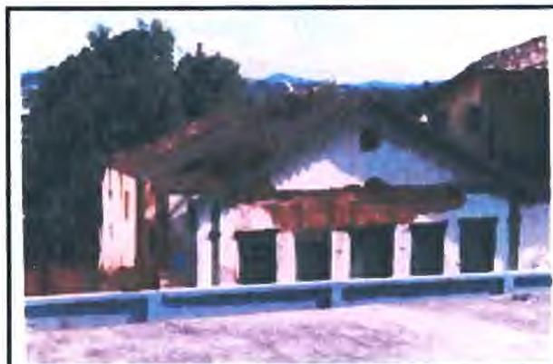
65: Vista da fachada principal da casa do Monsenhor Vicente em um pavimento, na rua Jacinto Alvares - 34/36; detalhe para ruptura do telhado, bem como da queda das paredes laterais do lado direito e do reboco na fachada principal.
