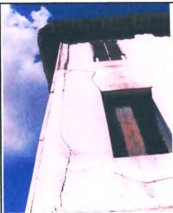
Foto 48: Rachadura vertical na parede dos fundos, no lado esquerdo.
