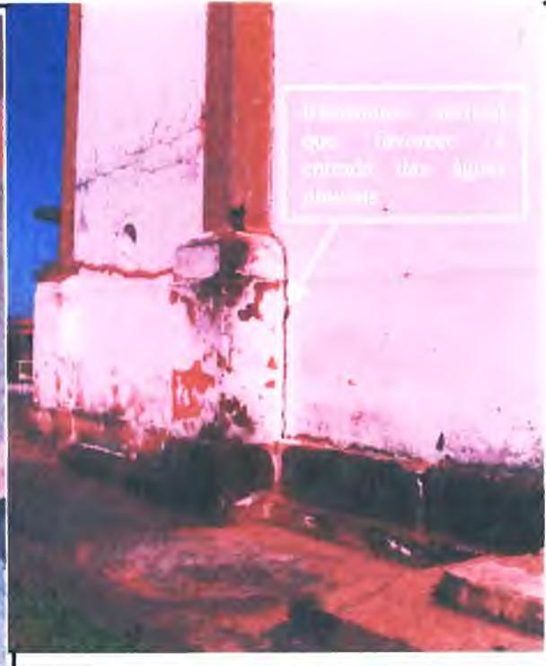
Foto 32: Fissuras, manchas e descolamento da pintura, na lateral esquerda.
