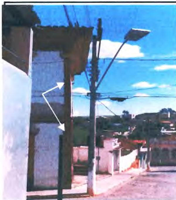
Foto 3: Detalhe para o desalinhamento do pórtico e conseqüente esforço adicional de flexão e torção nos pilares de madeira.
