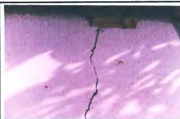
Foto 56: Detalhe para a rachadura mostrada na foto anterior, bem como o descolamento do reboco.
