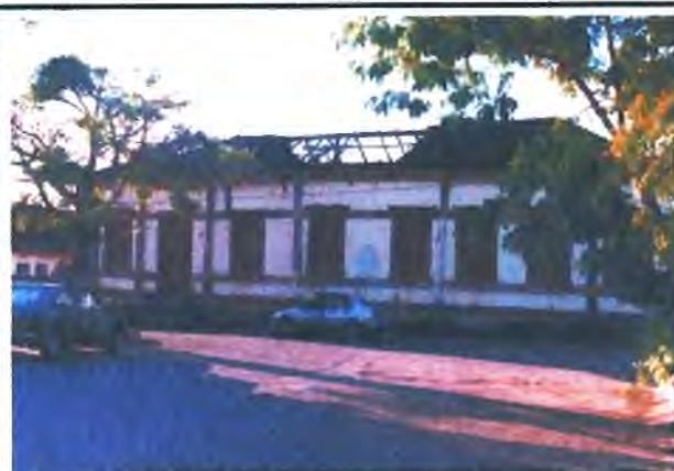
Foto 17: Vista frontal; detalhe para o péssimo estado do telhado, o que favorece a entrada de umidade e conseqüente apodrecimento da estrutura de madeira.
