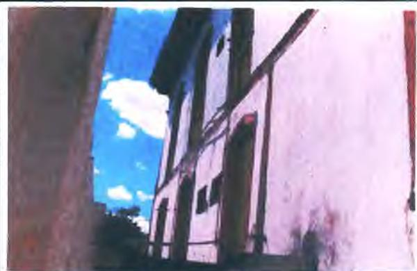
Foto 8: Vista dos fundos do Museu; detalhe para as manchas escuras na parede causadas pela umidade, bem como o tombamento do pórtico.
