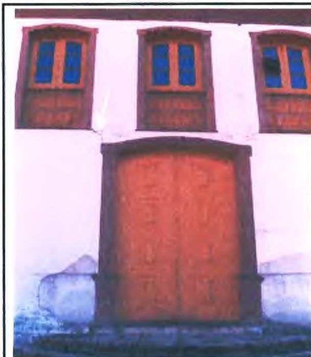
Foto 27: Fachada principal apresentando fissuras próximas aos vão das portas.
