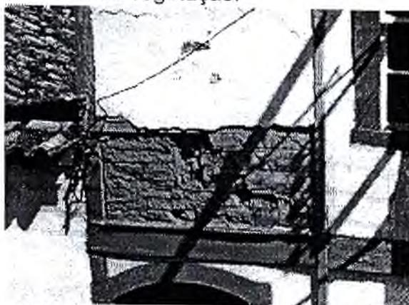
Foto 6 – Trechos de alvenaria em pau a pique sem reboco
