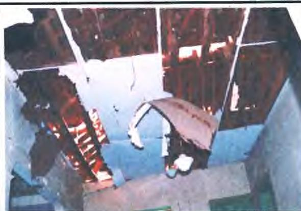
Foto 19: Detalhe para o forro e telhado danificados; a abertura no telhado favorece a entrada de umidade e o ataque dos cupins, bem como a ocorrência de mofo ou bolor.
