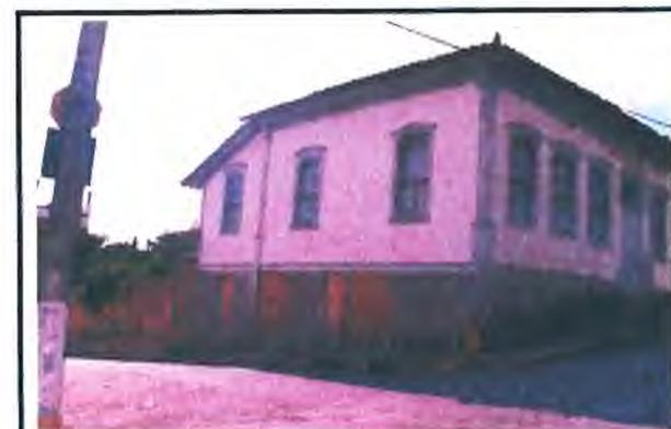
61: Vista da fachada lateral direita; detalhe para o descolamento do reboco e das sujidades.
