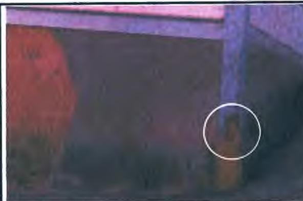
62: Detalhe para a coluna de madeira deteriorada, bem como da descolamento do reboco.
