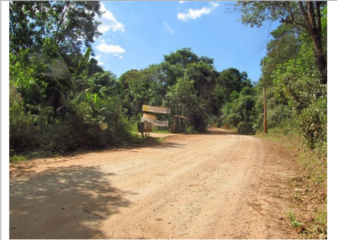
Figura 8- Trecho da Rodovia MG-030 onde se verificou maior concentração de casas. Foto da vistoria.
