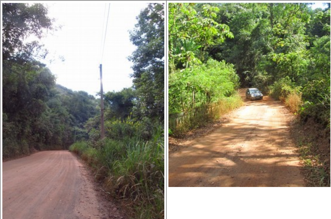
Figuras 2 e 3- Rodovia MG-030, em Itabirito. Fotos da vistoria.
