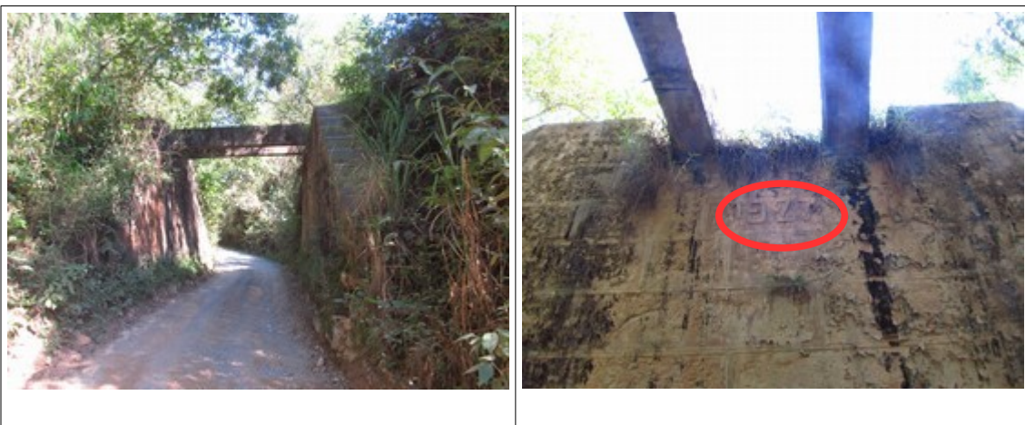
Figuras 41 e 42- Pontilhão existente no trecho da Rodovia MG-030, mais próximo a Rio Acima. Fotos da vistoria.
