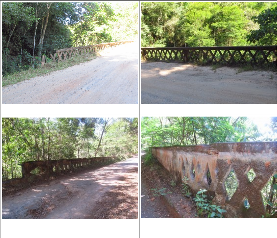
Figuras 35, 36, 37, 38, 39 e 40- Outras pontes existentes no trecho da Rodovia MG-030. Fotos da vistoria.
