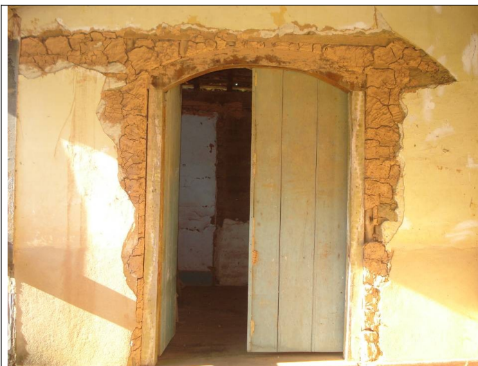
Figura 07 - Detalhe que mostra porta de entrada da Capela
