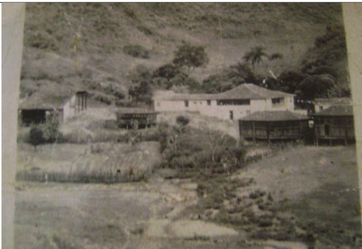
Figura 03 - Vista lateral e posterior da fazenda.
