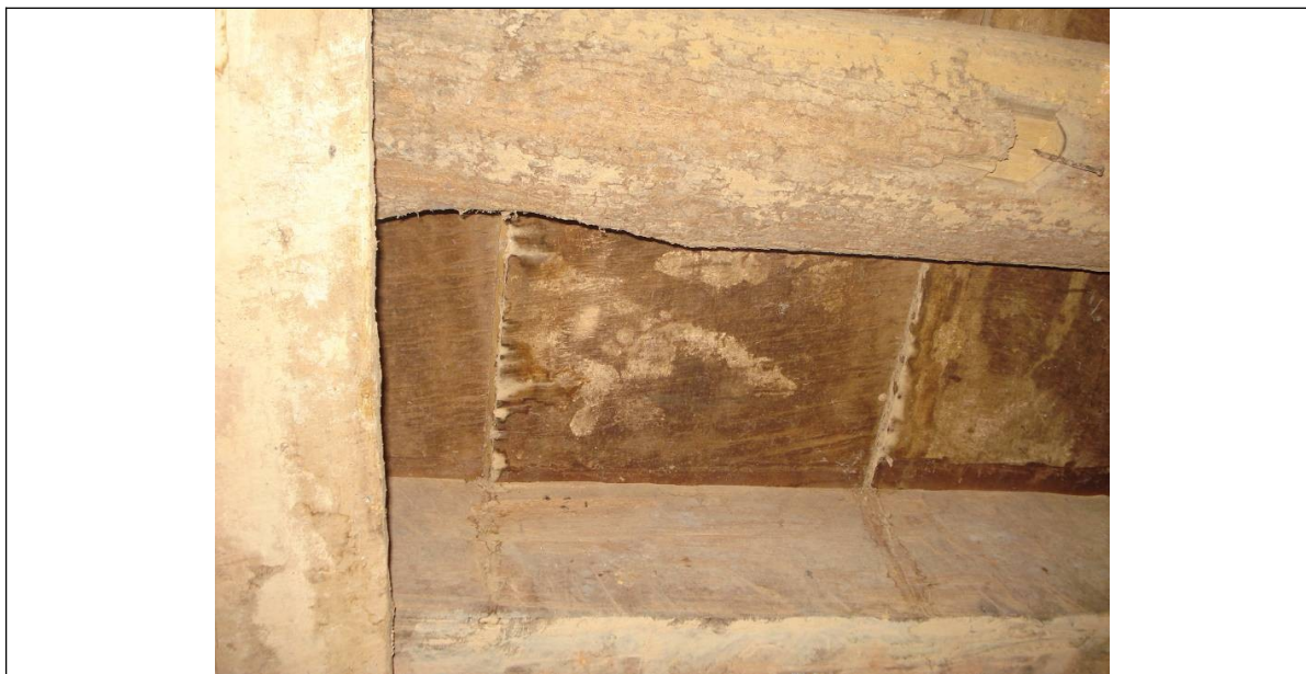
Figura 11 - Marcas dos pés no teto do porão que segundo relatos é de um dos escravos que trabalhava na fazenda.
