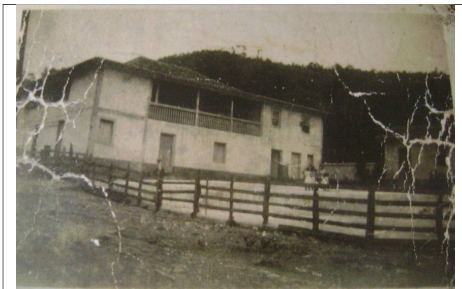
Figura 02 - Vista frontal da fazenda registrada em foto de 1950.
