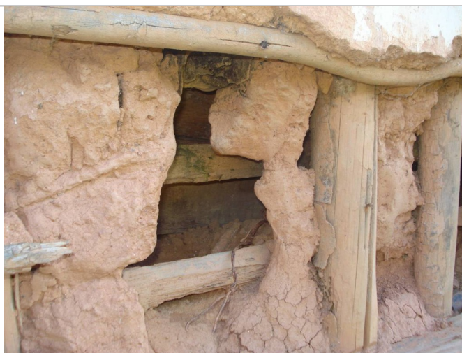
Figura 03 – Detalhe da técnica de pau-a-pique utilizada na construção.
