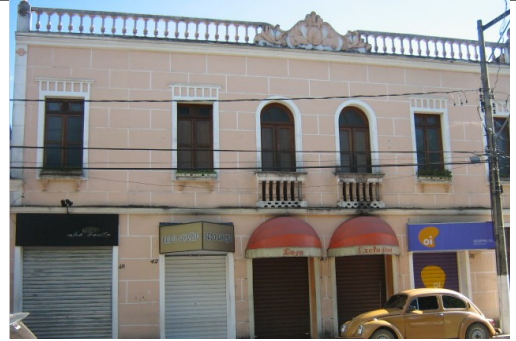
Figura 09 – Imagem de edificação de uso misto. Fonte: Documentação fotográfica acostada aos autos.
