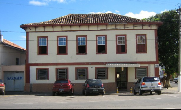
Figura 08 – Imagem do Hotel Regina em Rio Pomba. Fonte: Documentação fotográfica acostada aos autos.
