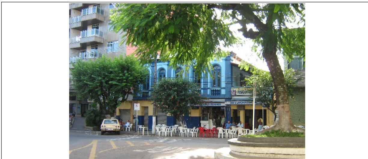
Figura 14- Imagem que mostra um prédio moderno no centro histórico de Rio Pomba. Fonte: Documentação fotográfica acostada aos autos.
