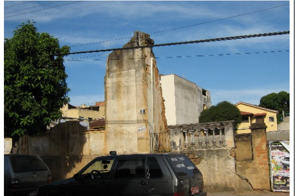
Figura 17-Imagem mostrando demolição de imóvel no centro histórico de Rio Pomba. Fonte: Documentação fotográfica acostada aos autos
