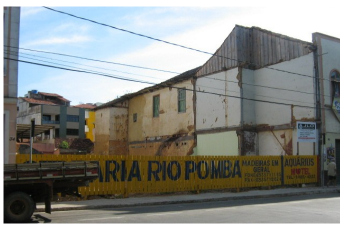
Figura 16- Imagem mostrando espaços vazios decorrentes de demolições no centro histórico de Rio Pomba. Fonte: Documentação fotográfica acostada aos autos
