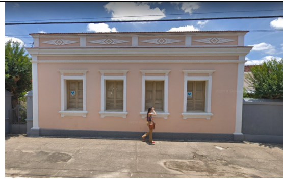
Figura 05 – Edificação de valor cultural na rua Dr. Esperidião.
