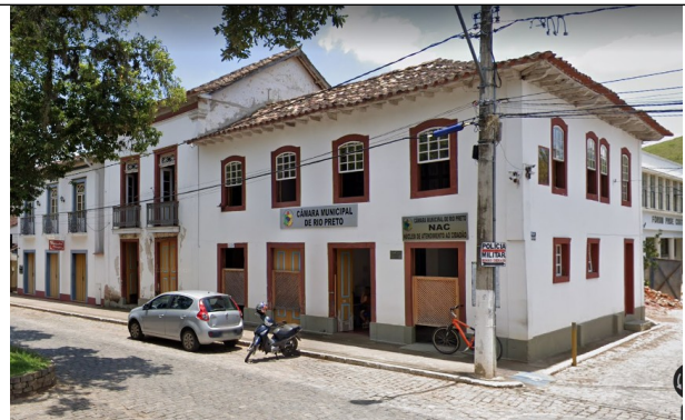
Figura 08 – Camara Municipal situada na rua Dr. Esperidião.
