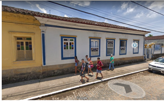
Figura 04 – Edificação de valor cultural na rua Dr. Esperidião.
