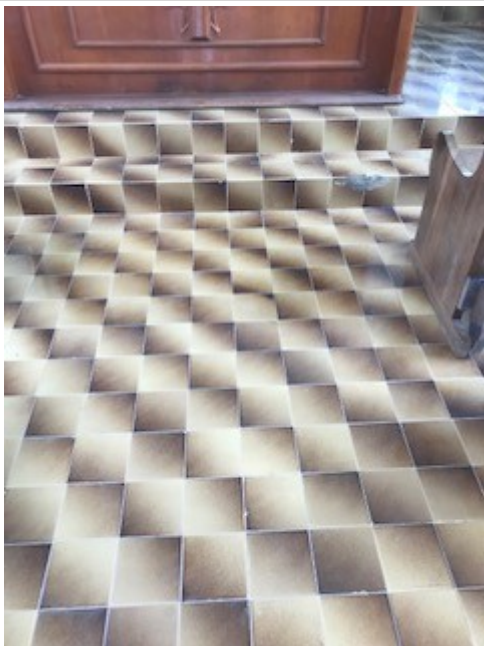
Figura 01 - Revestimento cerâmico atualmente existente.
