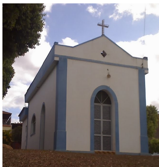
Figura 04 - Fachada da Igreja.
