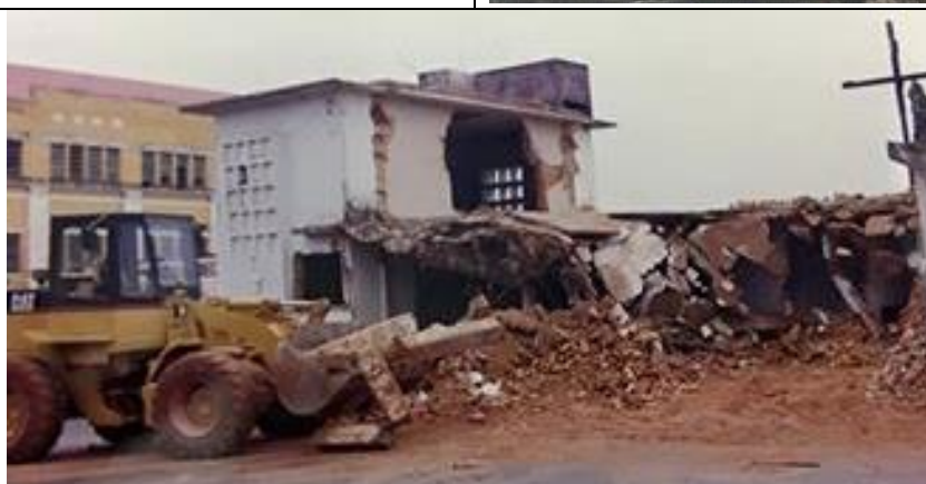
Figuras 01, 02 e 03 – Antiga rodoviária de São Gotardo, implantada entre as duas praças, e sua demolição. Nota-se nas imagens a presença do cruzeiro de madeira. Fonte: https://www.facebook.com/saogotardofotos/photos/pra%C3%A7a-s%C3%A3o-sebasti%C3%A3o-(fonte:-facebook/427894827382381/ e http://www.centroesturgente.com.br/wp-content/uploads/2017/01/RODOVI%C3%81RIA.jpg
