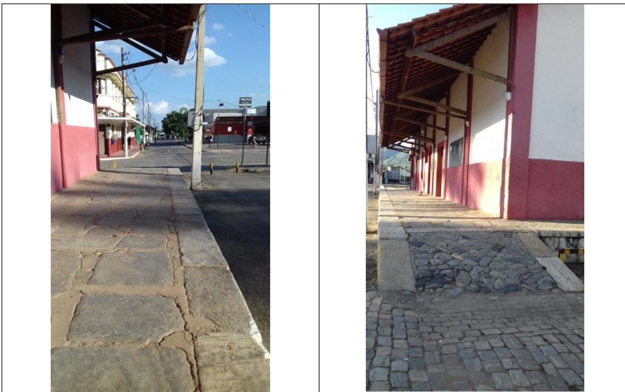
Figuras 04 e 05 - Piso lajeado de pedras da plataforma.
