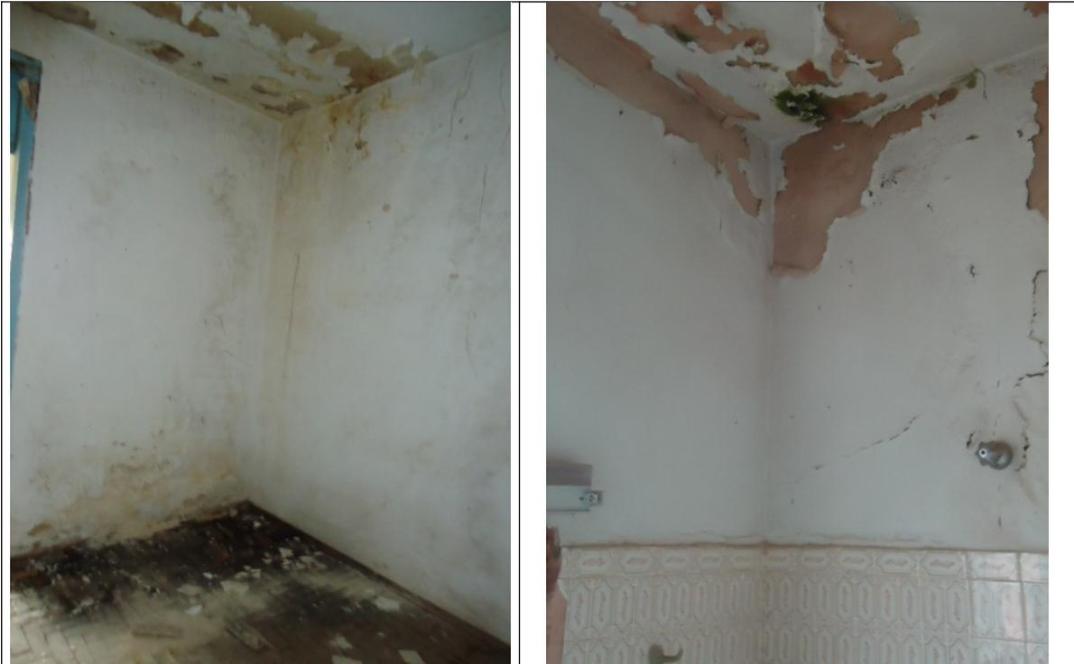
Figuras 14 e 15 – Infiltrações no interior da edificação da edificação, comprometendo os materiais de acabamento.
