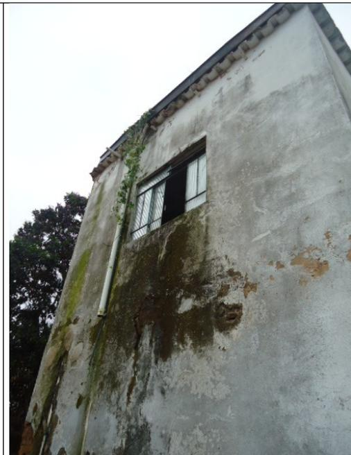
Figuras 12 e 13 – Infiltrações, manchas de umidade e descolamento do reboco no acréscimo existente nos fundos da edificação.
