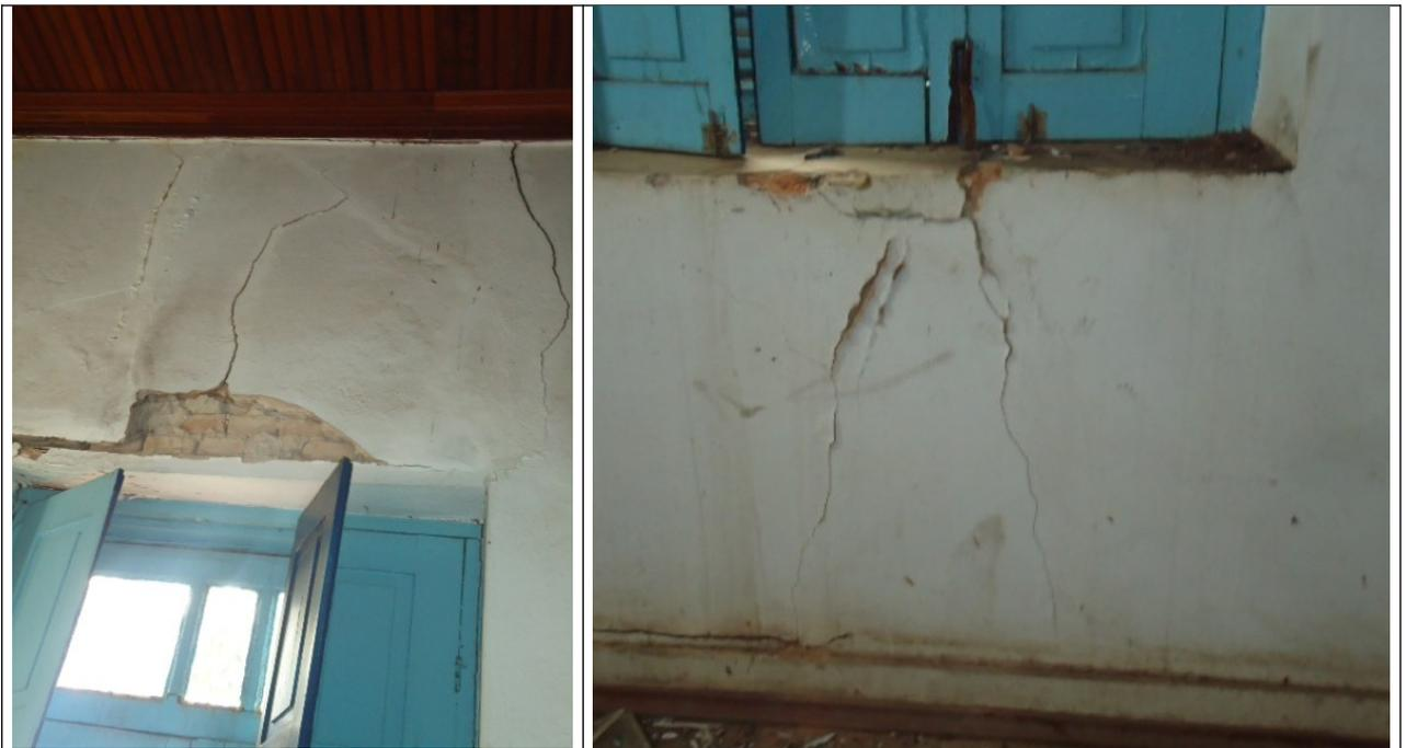
Figuras 17 e 18 – Trincas, fissuras, descolamento de reboco e pintura. Verifica-se também que estas esquadrias encontram-se em regular estado de conservação, sendo possível sua recuperação.
