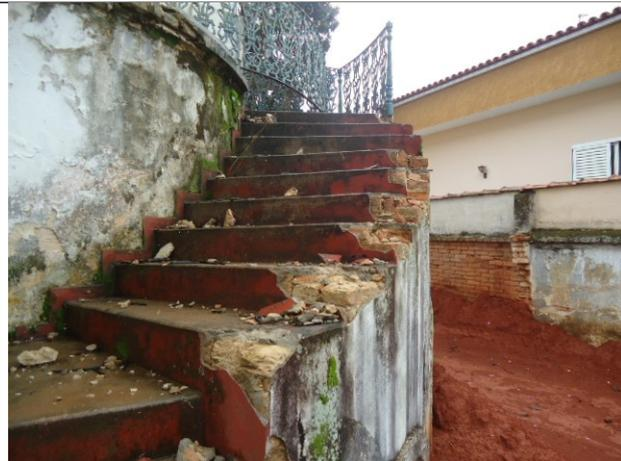
Figura 07 – Danos nos degraus da escada após remoção do guarda-corpo.
