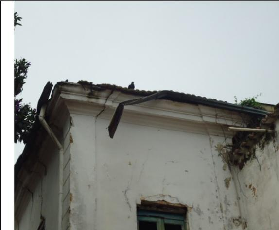
Figura 11 – Trecho danificado do telhado nos fundos da edificação.
