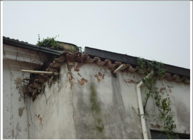
Figura 12 – Infiltrações e crescimento de vegetação no acréscimo existente nos fundos da edificação.
