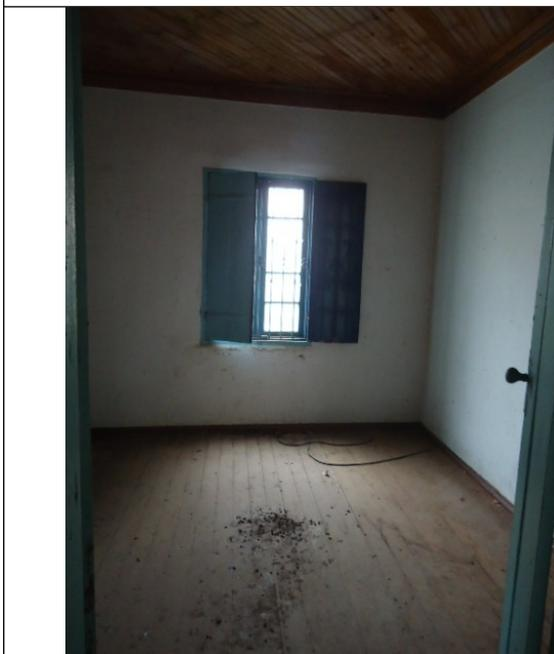
Figura 23 – Piso e forro de madeira em bom estado de conservação.
