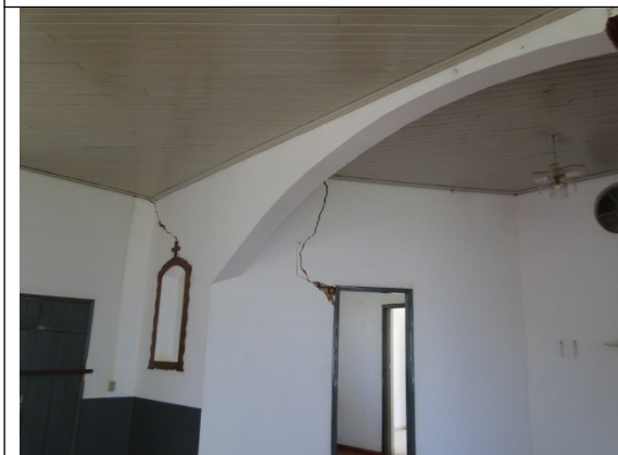
Figura 9 – detalhe das trincas apresentadas nas paredes internas
