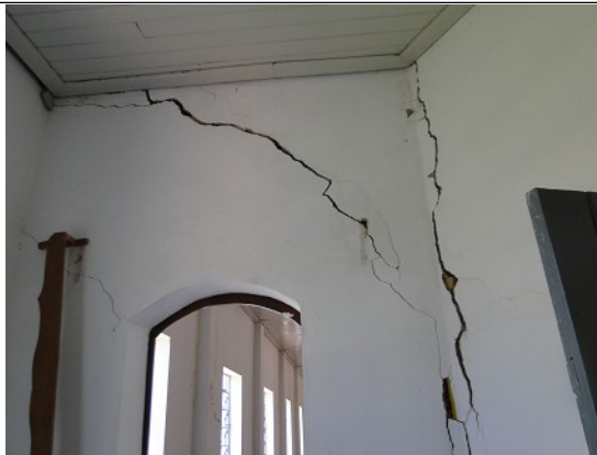
Figura 13- Danos nas alvenarias da edificação.
