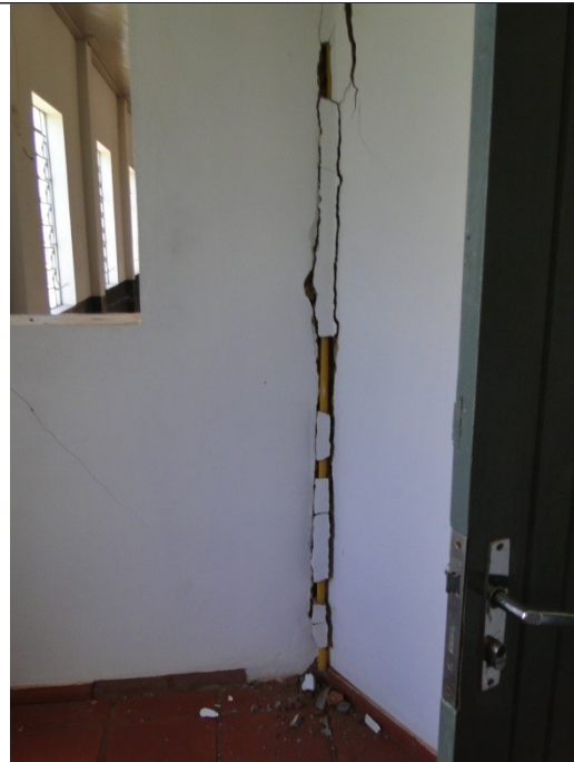
Figura 14 – detalhe da trinca no encontro das alvenarias, com a tubulação de rede elétrica exposta.
