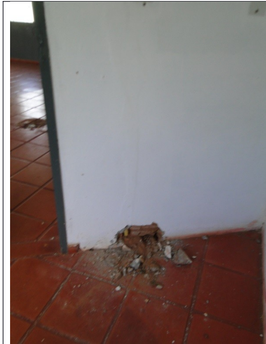
Figura 13- Danos nas alvenarias da edificação.
