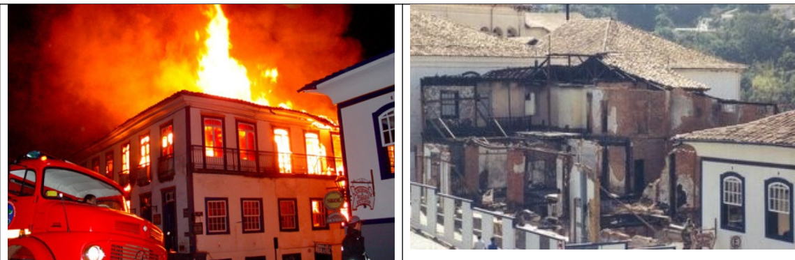
Figuras 10 e 11 – Registros dos danos causados no Hotel Pilão, pelo agente de deterioração: fogo.
