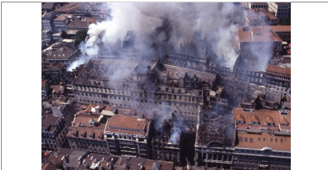
Figura 06 – Incêndio no bairro do Chiado em Portugal.
