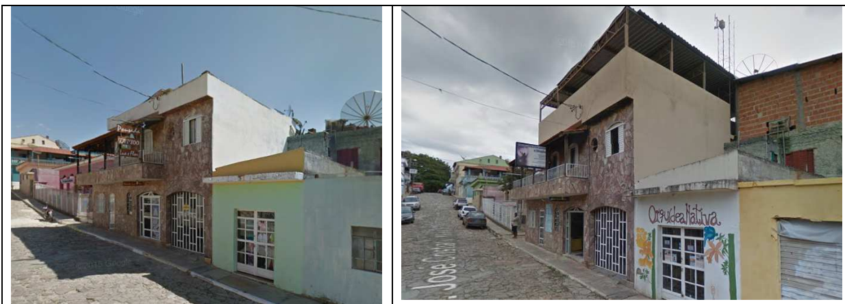
Figuras 03 e 04 – Construção de terraço / terceiro pavimento na edificação localizada na rua José Cristiano Alves nº 105, no entorno da praça Barão de Alfenas (Praça da Matriz). Imagens dos anos de 2011 e 2015, respectivamente.
