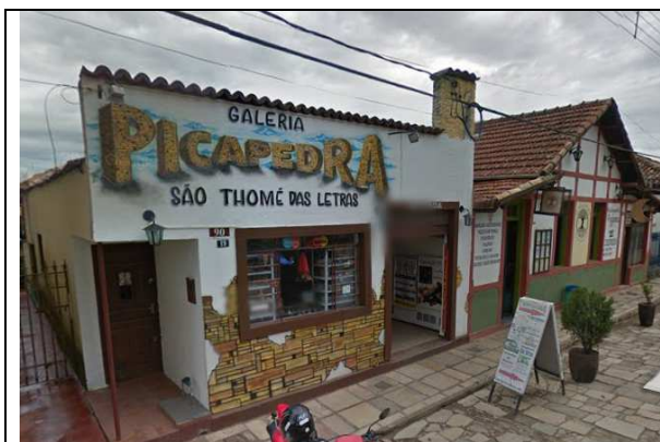
Figura 11 – Pintura publicitária em praticamente toda a fachada frontal do imóvel, instalação de engenho sobre a pista de rolamento.
