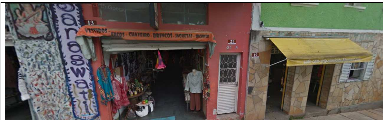
Figura 13 – Pintura sobre fachadas e falta de padronização de toldos.
