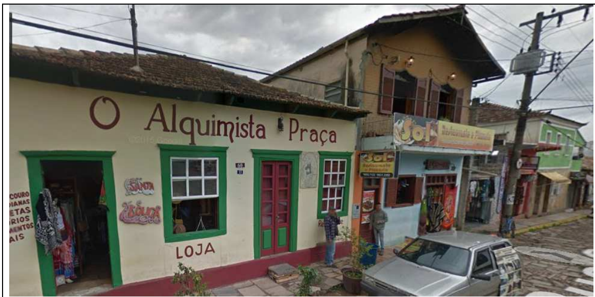
Figura 10 – Excesso de engenhos e pinturas sobre as fachadas dos imóveis.
