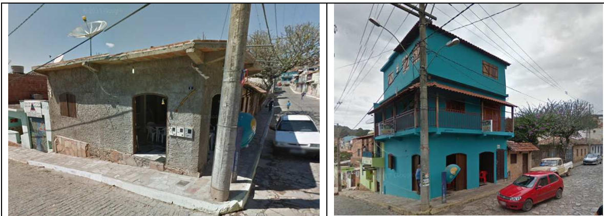
Figuras 07 e 08 – Reforma com ampliação de área em edificação situada na rua Camilo Rios nº 270, não respeitando as orientações do Iepha. Imagens dos anos de 2011 e 2015, respectivamente.
