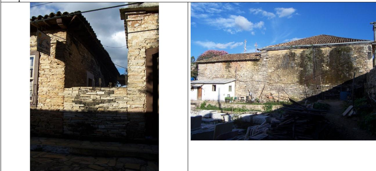
Figuras 03 e 04 – Muro e fachada lateral, com manchas de umidade.
