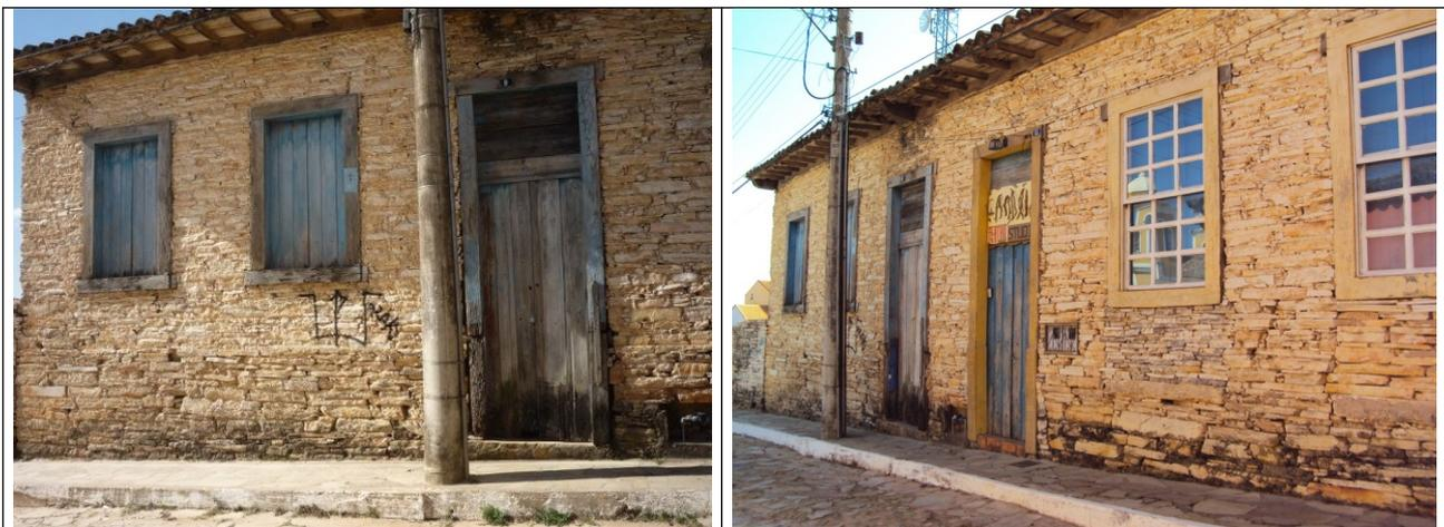
Figuras 01 e 02 – Fachadas da edificação. Verifica-se a presença de manchas de umidade nas alvenarias e comprometimento dos elementos de madeira.
