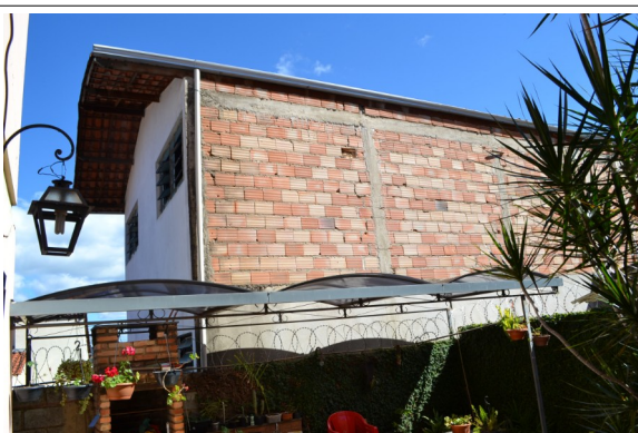
Figura 04 – A edificação vista a partir do imóvel vizinho.
