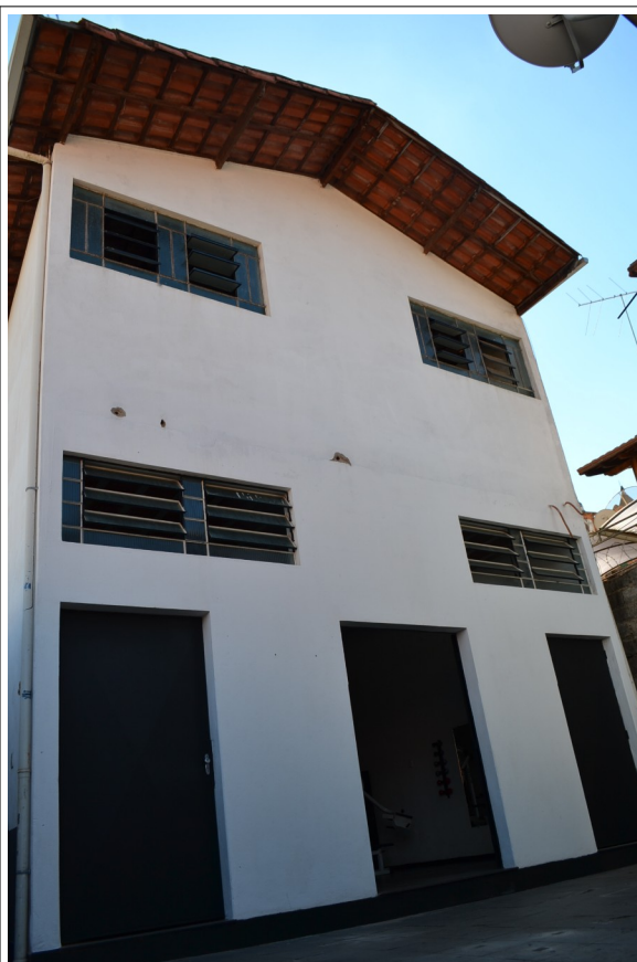
Figura 08 – Edificação junto ao alinhamento lateral direito.
