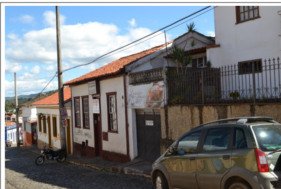
Figura 03 – vista da edificação a partir da rua São Pedro.
