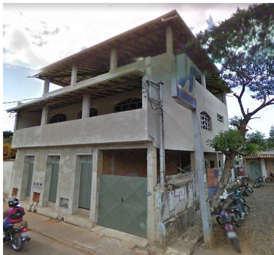
Figura 02 – Imagem da edificação em setembro de 2009. Fonte: Google Street View.
