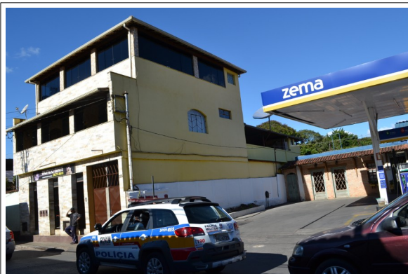
Figura 04 – Imagem da edificação em maio de 2018.
