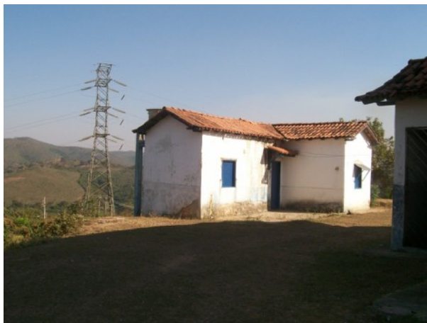
FIGURA 34– Casa do zelador localizada próxima da fachada posterior da Capela.
