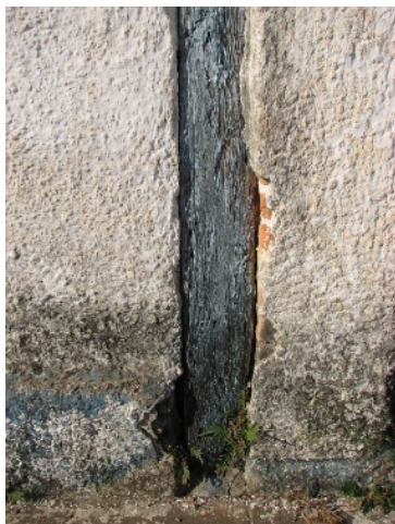
FIGURA 36 –Detalhe manchas de infiltração, estado ruim do madeiramento e presença de plantas invasoras.
