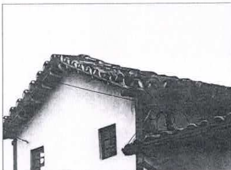
Fig 03 Vista parcial do telhado. Capela N. Sra. Bom Despacho, Sabará, fev. 2008
