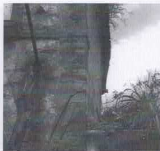
Imagens 37 e 38 – Inclinação e abaulamentos das paredes frontal e lateral esquerda
