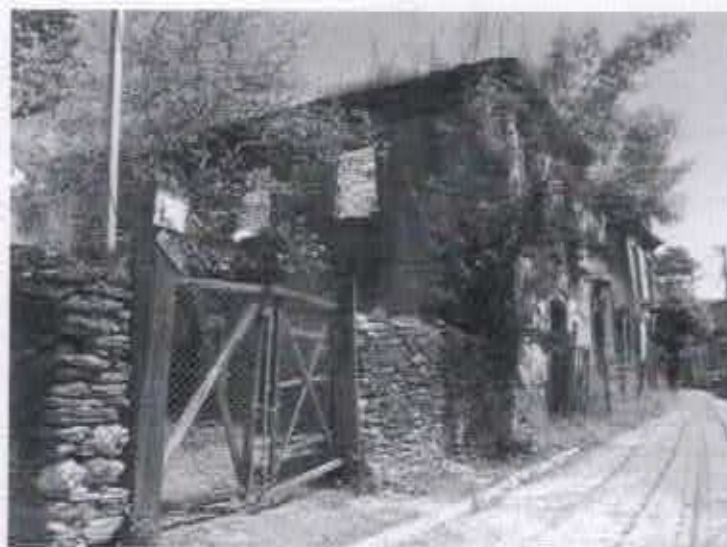
Imagem 21 – Foto recente da fachada principal do Casarão de Melo Viana, voltada à Rua Prof. Francisco Lopes de Azeredo
