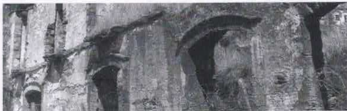
Imagem 01 - Detalhe da fachada principal do Casarão de Melo Viana
