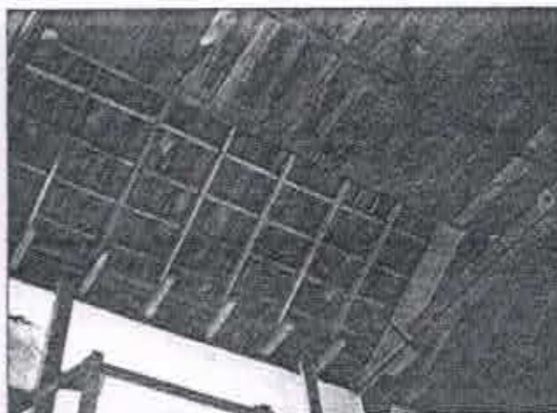
Fig. 07: Vista parcial da estrutura do telhado. Teatro Municipal, Sabará, fev. 2008
