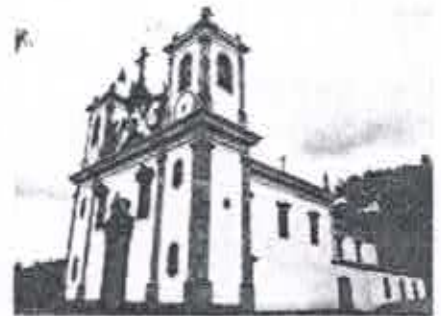
Igreja Nossa Senhora do Carmo, em Sabará. Outra importante edificação religiosa do século XVIII que exemplifica o barroco mineiro.
