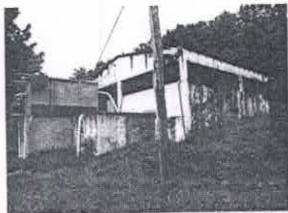
18. Estação de Tratamento de Água Foto: Viviane Corrado, dez/2007.
