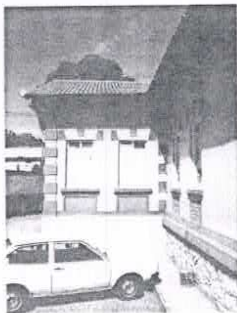
Vista da fachada frontal (acima à esquerda); vista geral do entorno (acima à direita); vista do volume anexo (à esquerda) Fotos: Gabriela Tassara, julho/07
