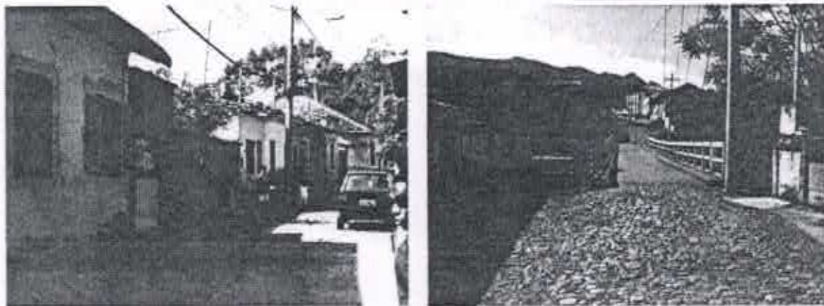
Fachada frontal (acima) e entorno (à esquerda Rua Prof. Francisco Lopes de Azeredo e à direita Rua Dom Pedro II) Fotos: Gabriela Tassara, maio/07
