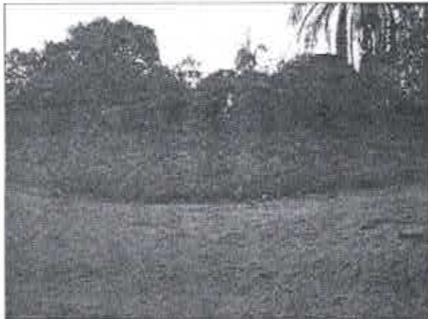
Ruina ao longo da Estrada, próximo ao povoado de Arraial Velho.
