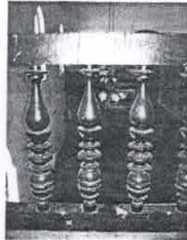
Detalhe dos balaústres. Fotografia: Flávia Melo Data: jan/2008
