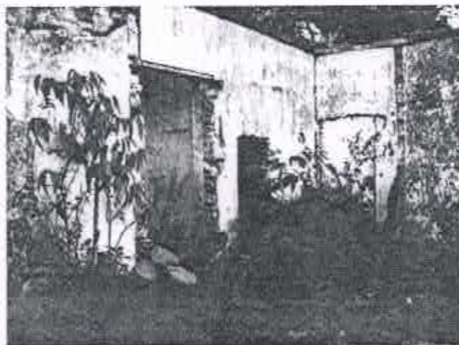
Vista da fachada frontal (acima à direita); seguida da vista do interior da ruína e vista geral do entorno imediato
