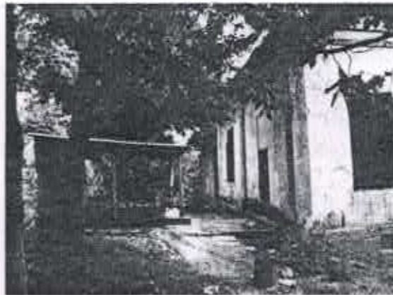
Residência; afastamento e fachada lateral direita. Foto: Viviane Corrado, dez/2007.
