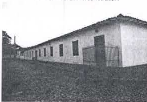
3. Atual Centro Técnico de Produção do Palácio das Artes Foto: Viviane Corrado, dez/2007.
