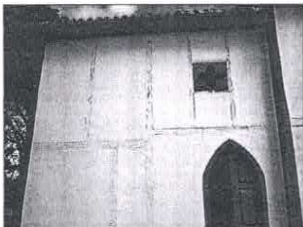
Fig. 01: Vista parcial da fachada lateral direita. Destaque para a estrutura autônoma de madeira. Capela Nossa Senhora do Rosário, Ravena, mar 2008
