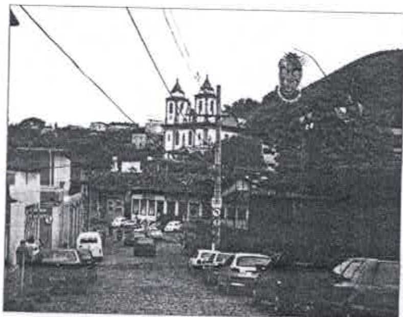
Fig. 17: Fiação elétrica da Rua São Pedro. Conjunto da Praça Bueno Brandão, Sabará, jan. 2008
