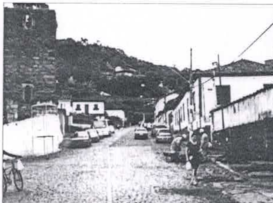
Fig. 16: Trecho de obras, ruídos intermitentes. Conjunto Rua Abreu Guimarães, Sabará, jan 2008
