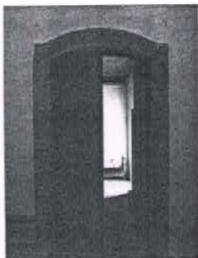
Fig. 23: Enquadramento em pedra em boas condições. Ig. Nsa. Sra. da Assunção da Lapa, Ravena, mar. 2008
