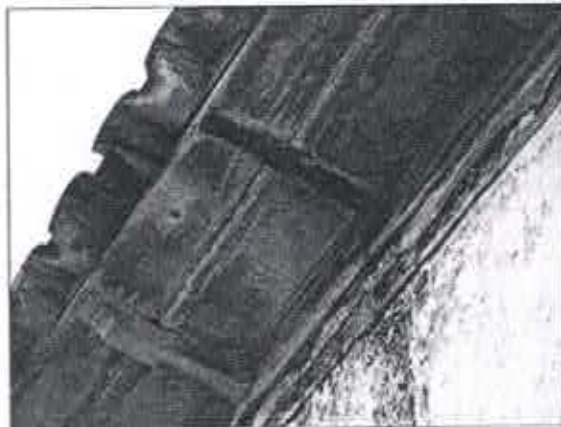
Fig. 11: Lacuna no madeiramento do guarda-pó. Igreja Nsa. Sra. da Assunção da Lapa, Ravena, mar. 2008
