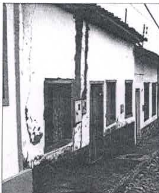
Fig. 19: Edificação de número 160. Conjunto Rua Abreu Guimarães, Sabará, jan.2008.
