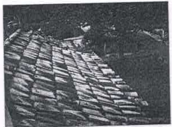
Fig. 07: Vista parcial do telhado. Capela Nossa Senhora do Rosário, Ravena, mar.2008
