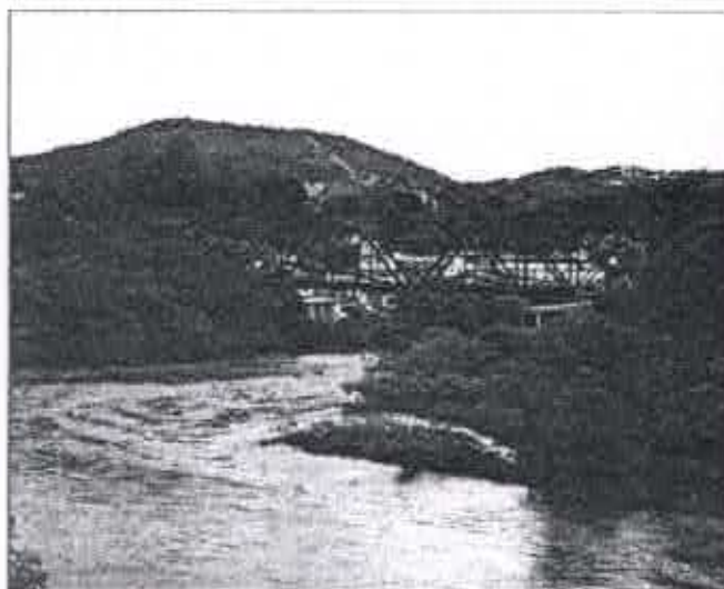
Fig. 13: Vista geral da ponte. Ponte Ferroviária sobre o Rio das Velhas, Sabará, jan. 2008
