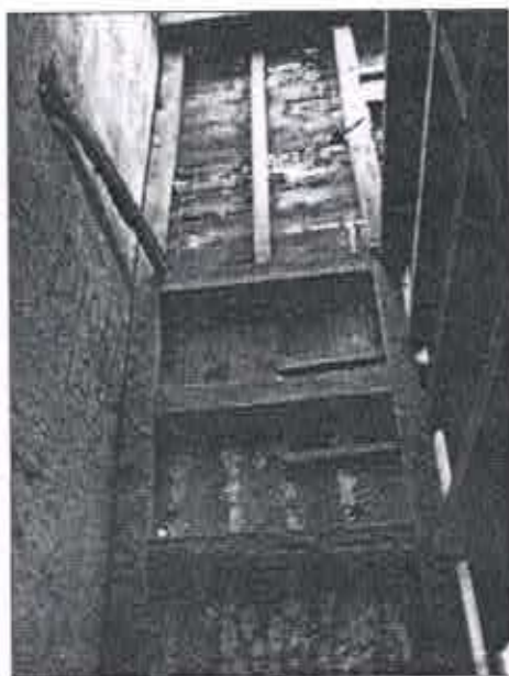
Fig. 45: Vista da parte posterior do retábulo-mor. Destaque para as madeiras degradadas. Ig. Nsa. Sra. da Assunção da Lapa, Ravena, mar. 2008.
