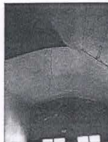
Fig 05 e 06: Fissuras na parede frontal, próximas aos vãos das janelas. Ig. Nsa. Sra. da Assunção da Lapa, Ravena, mar. 2008
