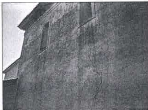
Fig. 13 e 14: Trincas no reboco dão revestimento externo e caiação desgastada. Ig. Nsa. Sra. da Assunção da Lapa, Ravena, mar. 2008
