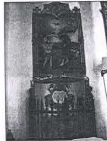
Fig 19 e 20: Pinturas parietais apresentando pequenas falhas, fissuras e pontos com descolamento. Igreja Nsa. Sra. da Assunção da Lapa, Ravena, mar. 2008.
