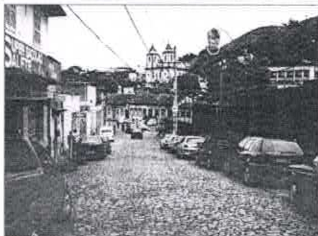
Fig 01: Pavimentação em bom estado na rua São Pedro, próximo à praça Bueno Brandão. Conjunto da Praça Bueno Brandão, Sabará, jan. 2008
