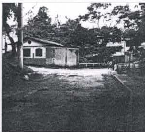
Fig. 14: Entorno imediato na av. Albert Scharlé. Ponte Ferroviária sobre o Rio das Velhas, Sabará, jan. 2008
