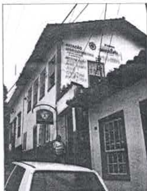
Fig. 23: Edificações de dois pavimentos. Conjunto Rua Abreu Guimarães, Sabará, jan.2008
