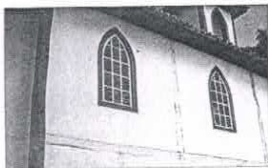
Fig. 16: Vista externa das janelas. Capela Nossa Senhora do Rosário, Ravena, mar. 2008
