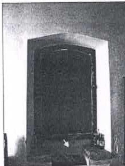
Fig. 22: Vista interna da janela. Destaque para lacuna do enquadramento em madeira. Ig. Nsa. Sra. da Assunção da Lapa, Ravena, mar. 2008
