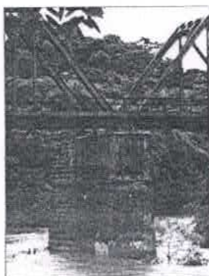
Fig. 01 e 02: Detalhes do pilar central com intensas manchas de umidade.
