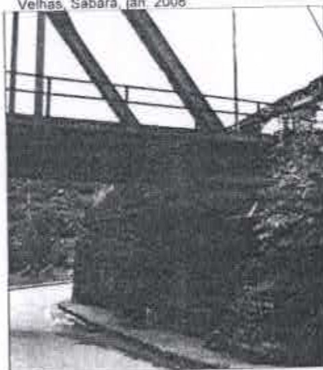
Fig. 05 e 06: Vegetação crescente próximo ao pilar. Ponte Ferroviária sobre o Rio das Velhas, Sabará, jan. 2008
