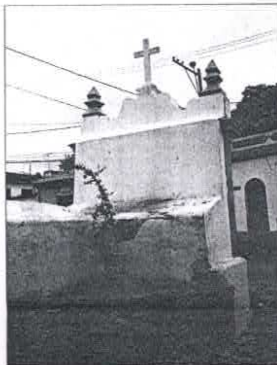
Fig. 03: Vista atual da fachada posterior do Chafariz. Destaque para o jardim criado após a restauração.
