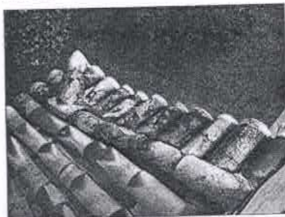
Fig. 08: Detalhe das telhas com bolores. Capela Nossa Senhora do Rosário, Ravena, mar.2008
