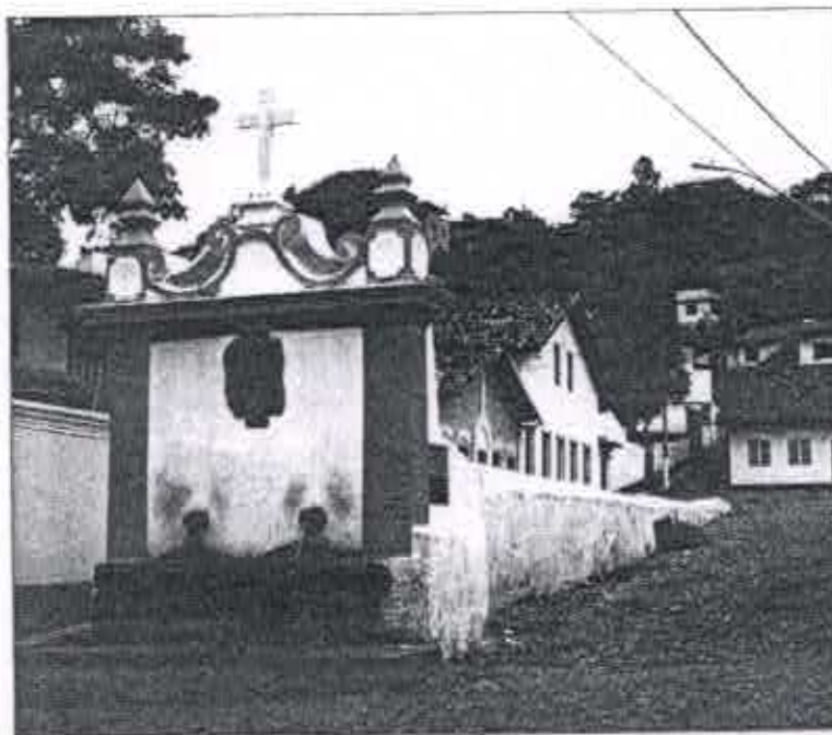
Fig 01: Fachada frontal do Chafariz. Chafariz do Kaquênde: Sabará, jan 2008
