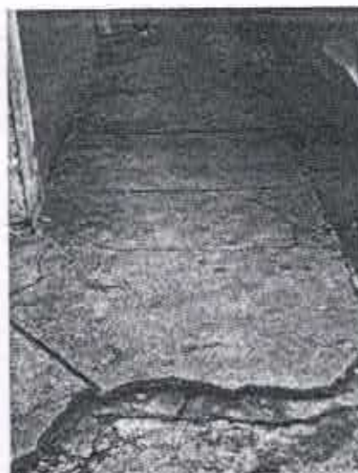
Fig. 12 e 13: Trincas e fissuras no passeio cimentado e perda do recobrimento em alguns pontos Conjunto da Praça Bueno Brandão, Sabará, jan 2008
