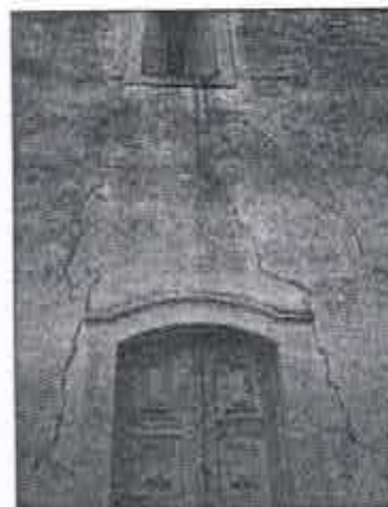
Fig. 13 e 14: Trincas no reboco dão revestimento externo e caiação desgastada. Ig. Nsa. Sra. da Assunção da Lapa, Ravena, mar. 2008
