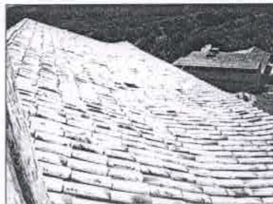
Fig.08: Vista parcial do manto da cobertura. Iq. Nsa. Sra. da Assunção da Lapa, Ravena, mar. 2008
