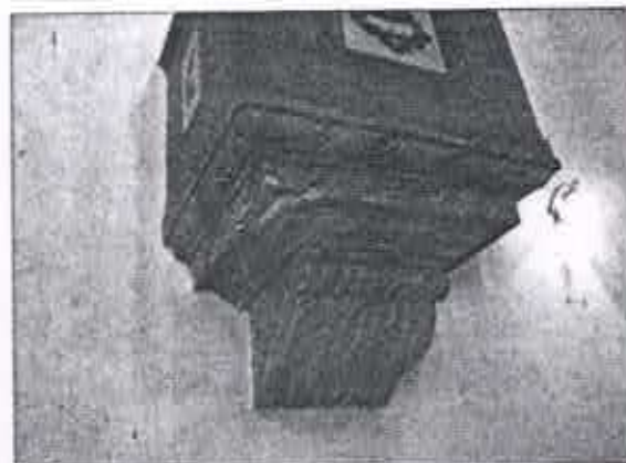
Fig. 48: Púlpito com perda no seu suporte. Ig. Nsa. Sra. da Assunção da Lapa, Ravena, mar. 2008
