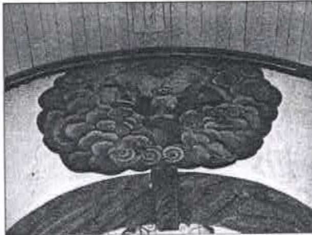
Fig 19 e 20: Pinturas parietais apresentando pequenas falhas, fissuras e pontos com descolamento. Igreja Nsa. Sra. da Assunção da Lapa, Ravena, mar. 2008.
