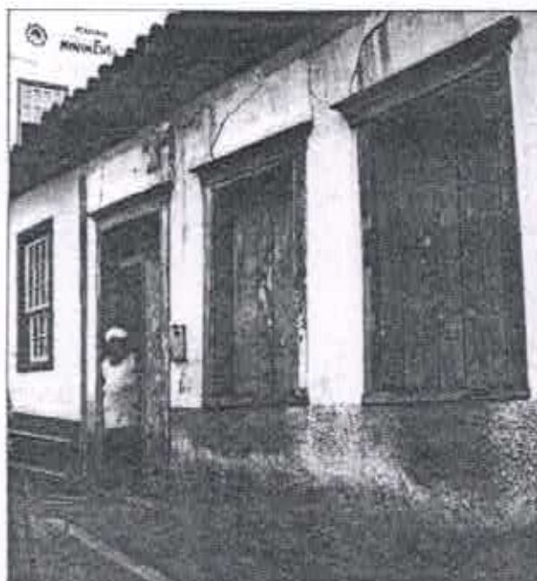
Fig. 20: Edificação de número 176. Conjunto Rua Abreu Guimarães, Sabará, jan.2008
