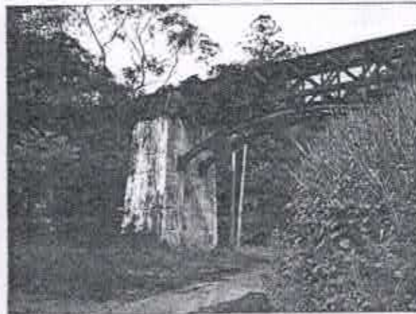
Fig. 01 e 02: Vista geral da ponte com pilares em concreto e estrutura metálica. Ponte Ferroviária sobre o Rib. Gaia, Sabará, fev. 2008
