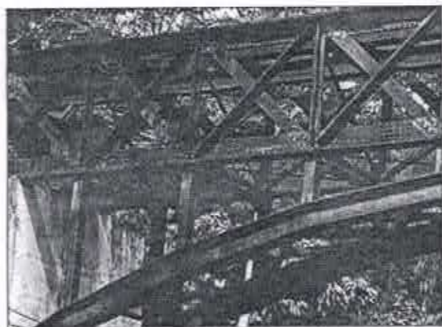
Fig. 05 e 06: Detalhe da oxidação da estrutura metálica. Ponte Ferroviária sobre o Rib. Gaia, Sabará, fev. 2008
