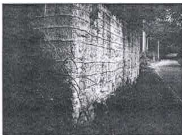
Fig. 13 e 14: Pilares com manchas de umidade e escorrimento. Ponte Ferroviária sobre o Rib. Gaia, Sabará, fev. 2008
