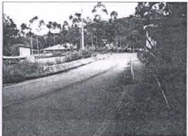
Fig 20: Ponte rodoviária próxima ao pontilhão. Ponte Ferroviária sobre o Rib. Gaia, Sabará, fev. 2008
