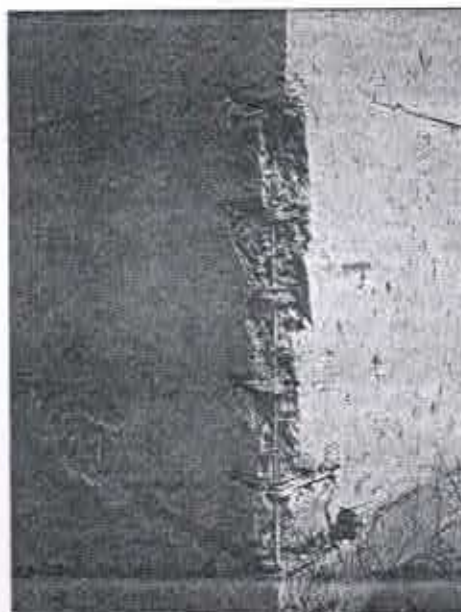
Fig. 03 e 04: Detalhe da ferragem estrutural dos pilares exposta. Ponte Ferroviária sobre o Rib. Gaia, Sabará, fev. 2008
