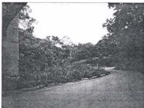
Fig 15: Estrada sob ponte. Ponte Ferroviária sobre o Rib. Gaia, Sabará, fev. 2008
