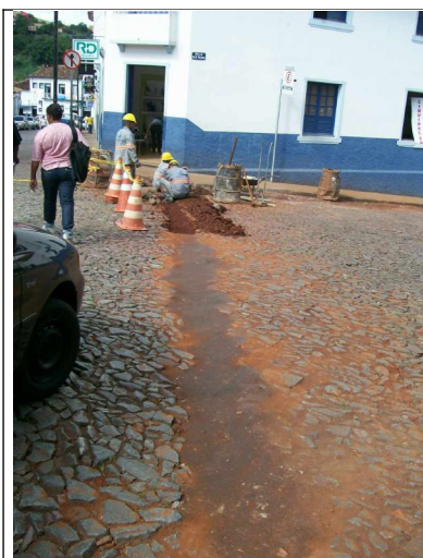
Figura 07 – Trecho em obras.
