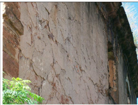
Figura 08 – Reboco trincado.
