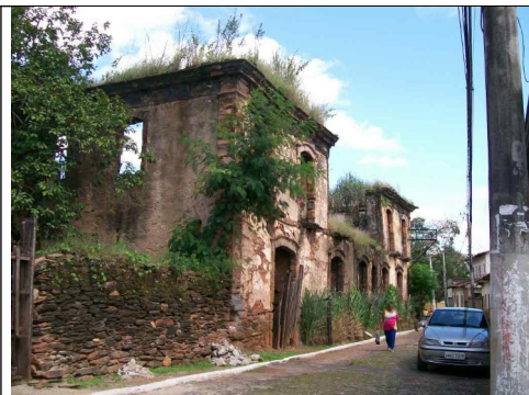
Figura 03 – Fachada principal do casarão.
