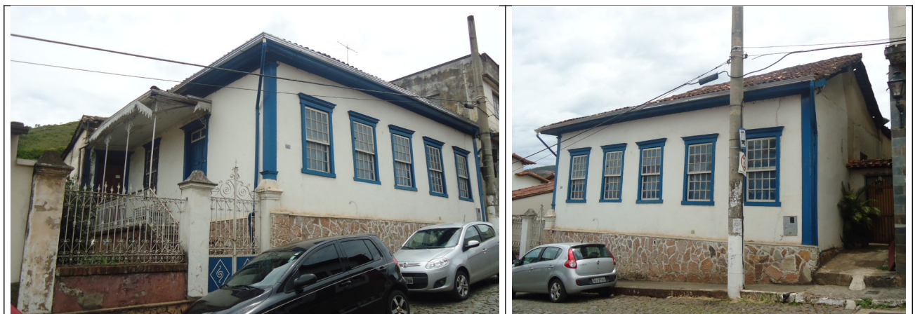
Figuras 14 e 15 – Fachadas do imóvel em regular estado de conservação.
