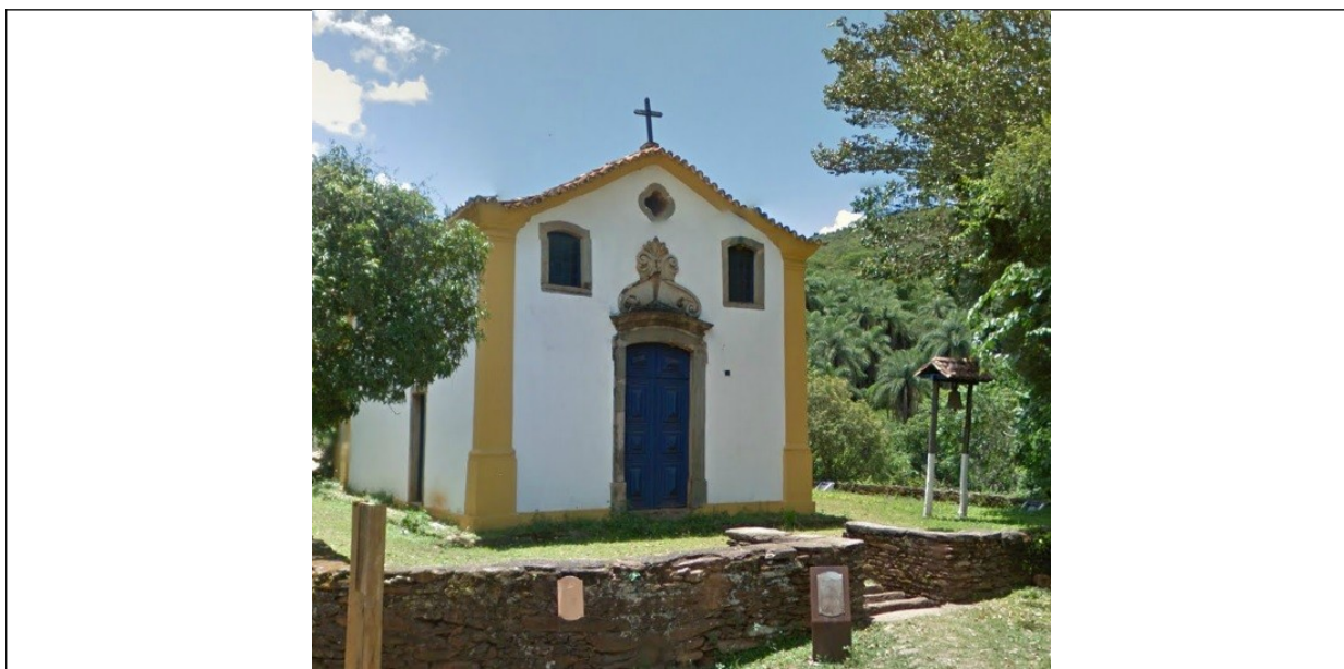
Figura 01 – Igreja Sant’Ana, localizada na rua Paraopeba, s/n, em Arraial Velho de Sant’Ana, Sabará. Fonte: Google Street View, acesso em fev/2015.
