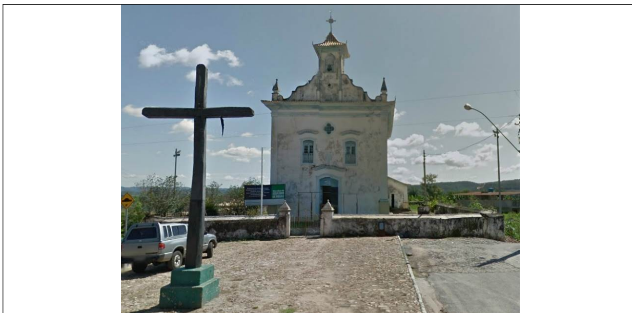
Figura 01 – Igreja Matriz Nossa Senhora da Assunção, localizada à Praça Nossa Senhora da Assunção, nº 05, em Ravena, Sabará. Fonte: Google Street View, acesso em fev/2015.
