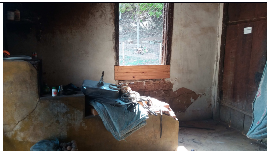
Figura 05 - Imagem interna da edificação.
