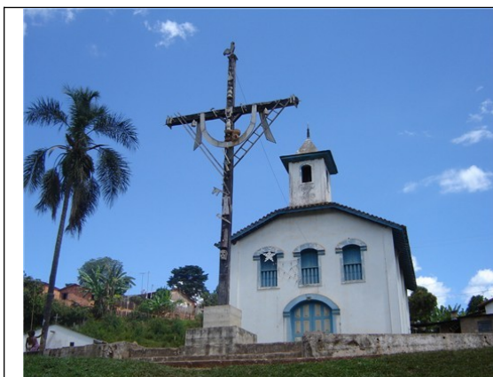
Figura 39 – Igreja de São Sebastião da Vargem Alegre Fonte: Prefeitura de São Gonçalo do Rio Abaixo Acesso em 12 de julho de 2012.
