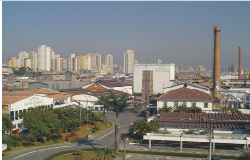
FIGURA 06 – Conjunto das edificações da Saint – Gobain, antiga Vidraria Santa Marina. Remanescentes tombados: Torre de energia; duas chaminés (fornos 5 e 20) e dois edifícios (Amazonas e São Paulo). Resolução de Tombamento 05/09. Fotografia: Angela Rösch Rodrigues, 2008.
