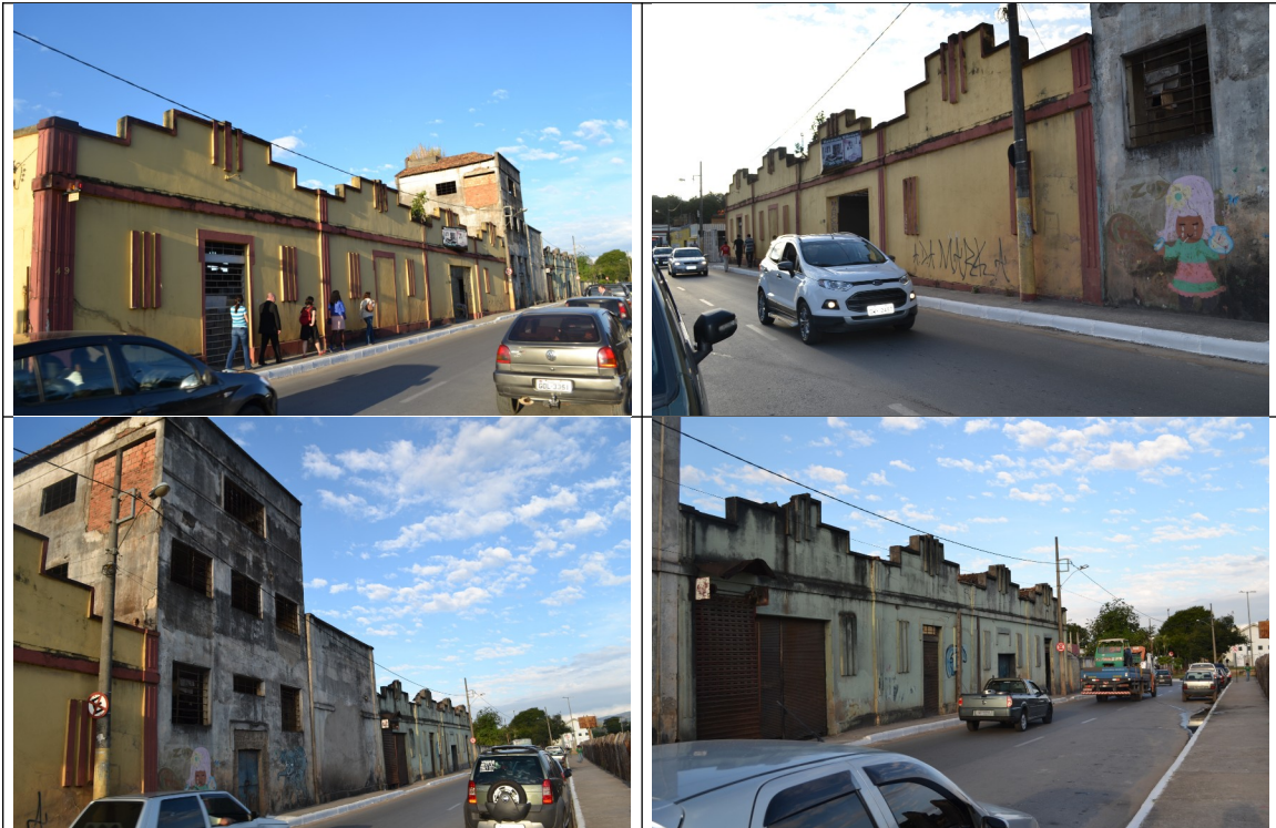
Figuras 23, 24, 25 e 26 – Aspecto da fachada voltada para a Travessa Dona Quita.
