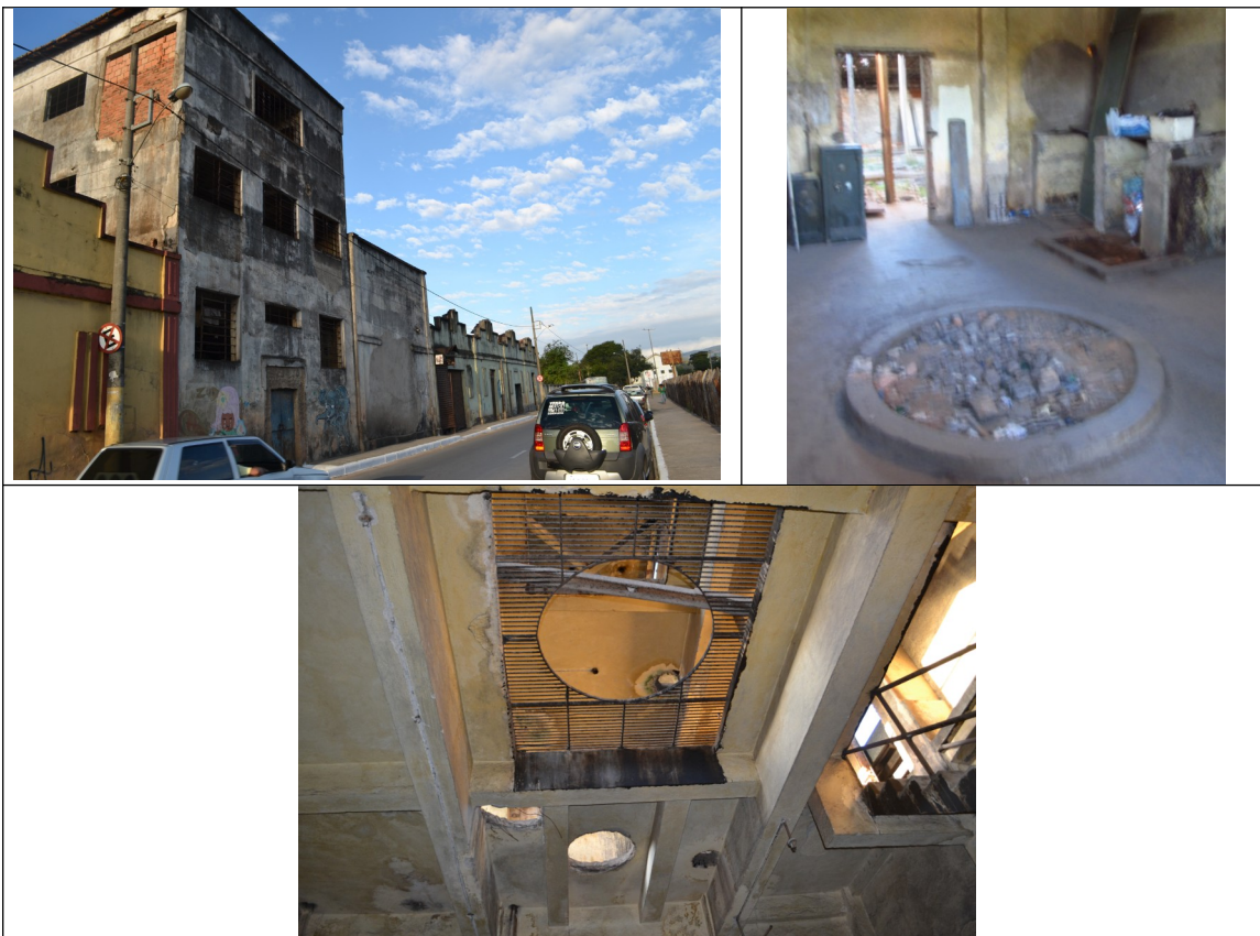
Figuras 14, 15 e 16 - Imagem externa e interna do prédio que compõe a fachada da antiga Fábrica de Sabão de Santa Luzia.
