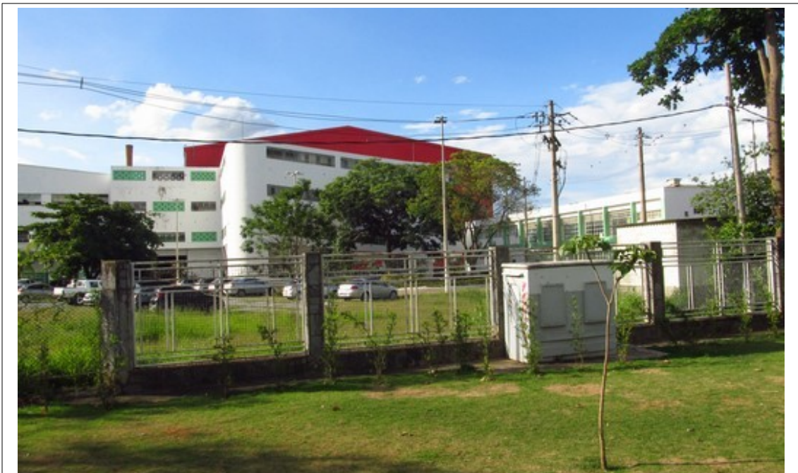
Figura 75- Prédio do Frigorífico, destacando-se no conjunto industrial. Fonte: Foto da vistoria.
