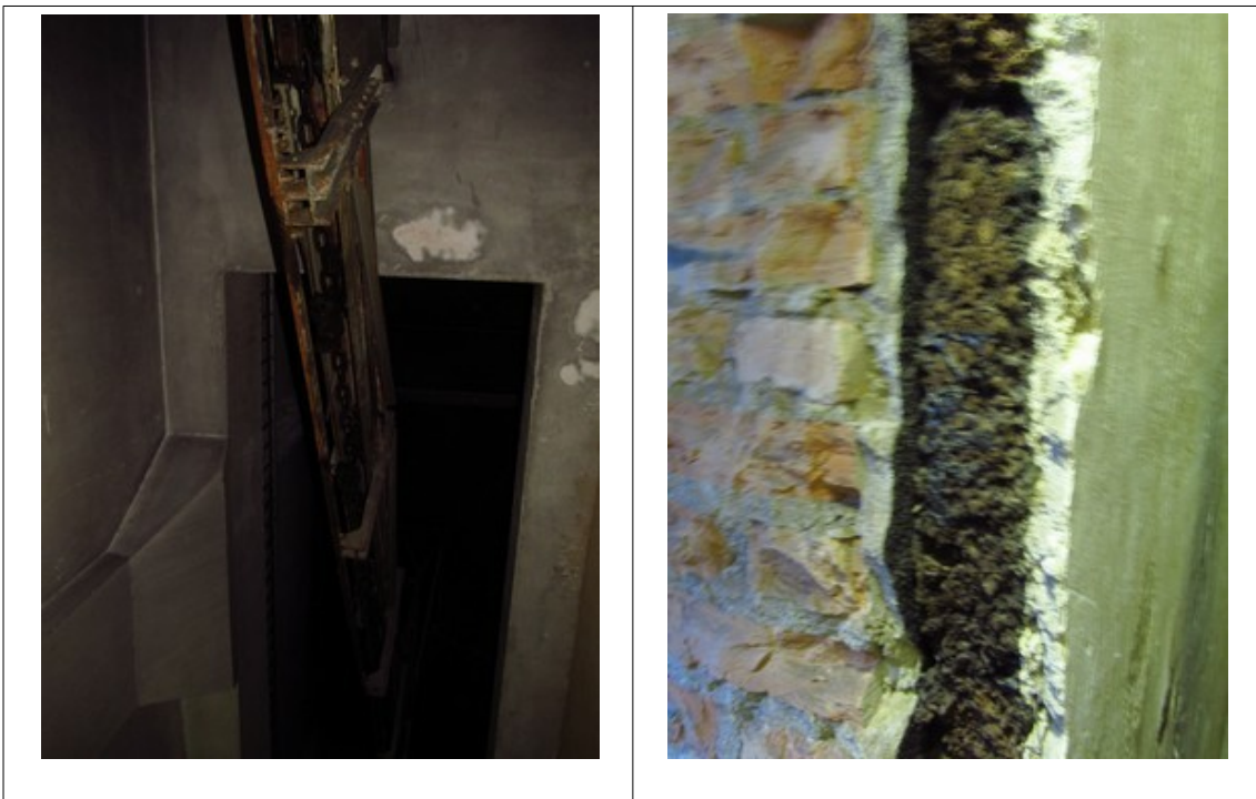
Figuras 110 e 111- Equipamento denominado “noria” existente num cômodo nos fundos do Arquivo Municipal e parede revestida com cortiça. Fotos da vistoria
