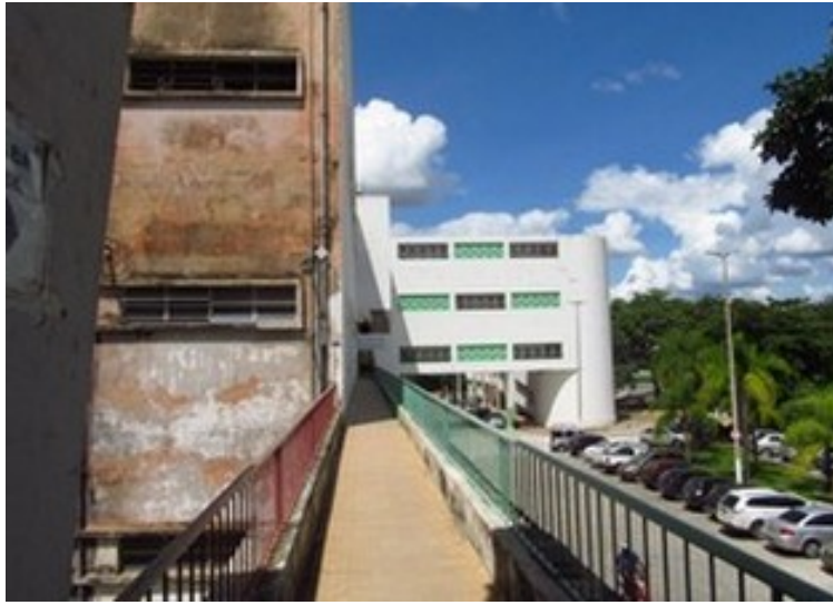
Figuras 14, 15 e 16- Prédio das Conservas. Fonte: Laudo Pericial de Avaliação, 2015, e fotos da vistoria.
