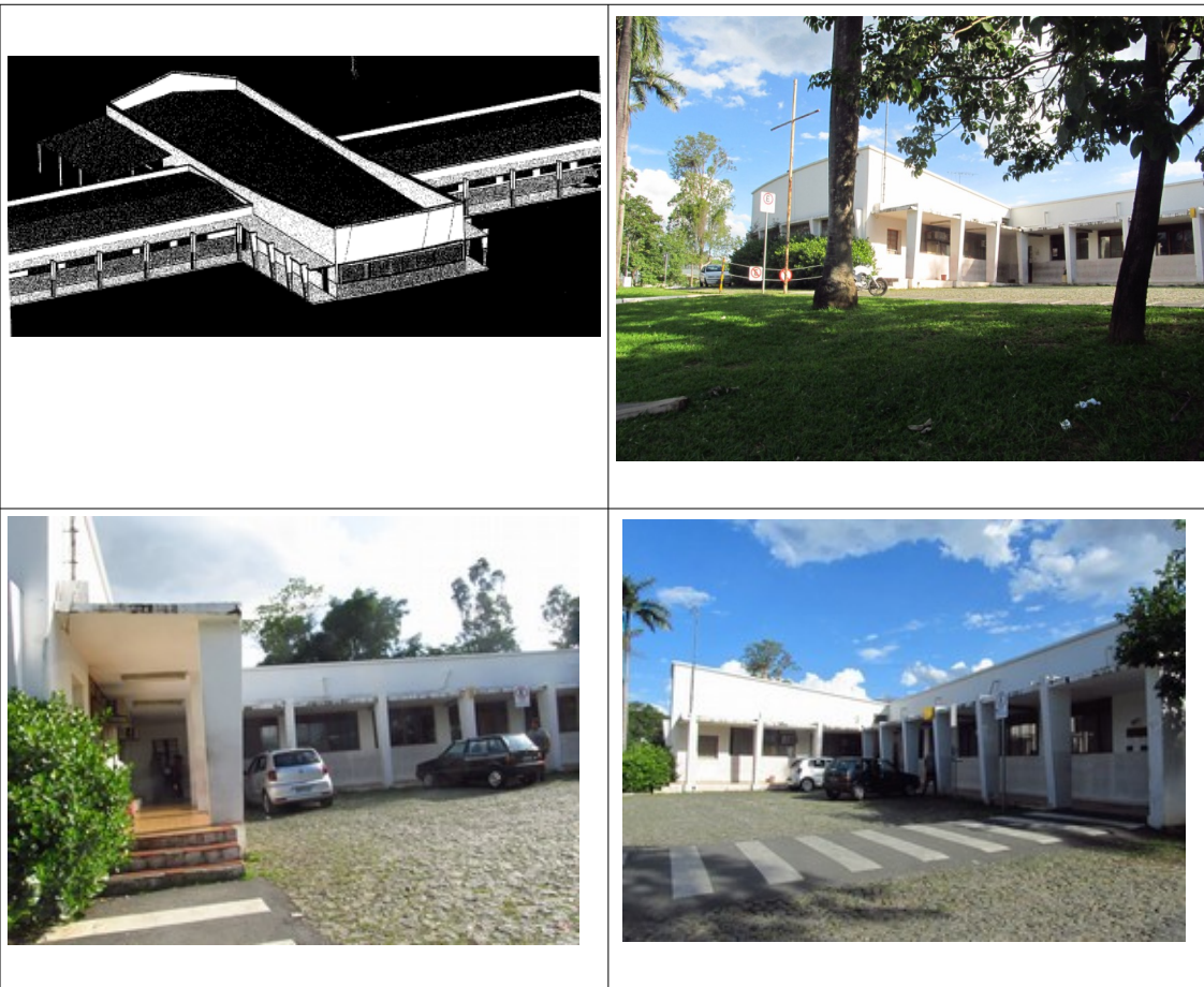
Figuras 97, 98, 99 e 100- Antigo refeitório da Frimisa, atual Detran. Fonte: Laudo Pericial de Avaliação, 2015, e fotos da vistoria.
