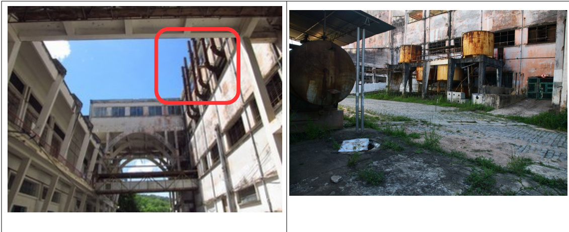
Figuras 108 e 109- Equipamentos e maquinários remanescentes do antigo frigorífico Frimisa. Fonte: Fotos da vistoria.
