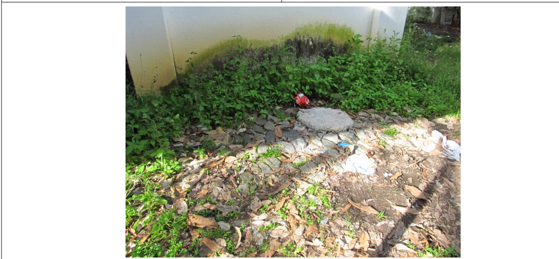
Figuras 101, 102, 103, 104 e 105- Antigo refeitório da Frimisa, atual Detran- parte dos fundos. Fonte: Fotos da vistoria.
