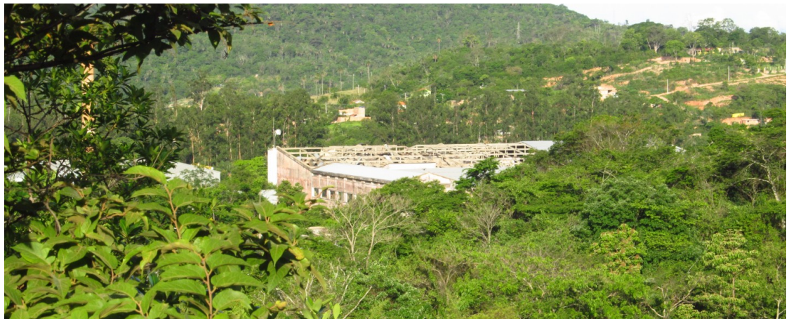
Figura 112- Imagem parcial do prédio do frigorífico a partir do prédio de tratamento de água da Frimisa. Fonte: Foto da vistoria.
