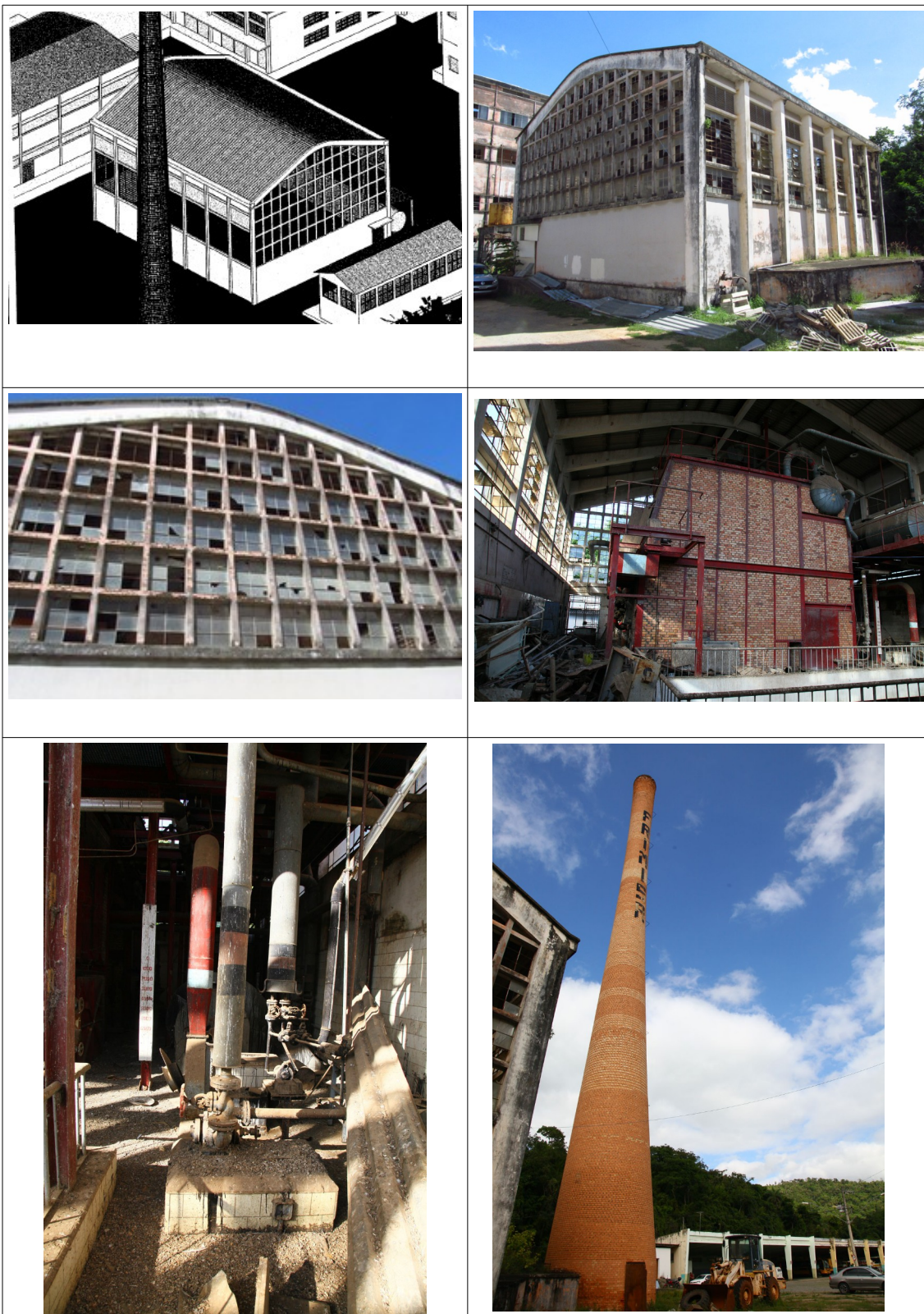
Figuras 52, 53, 54, 55, 56 e 57- Conjunto formado pela Caldeira e pela Chaminé- imagens externas e internas da Caldeira. Fonte: Laudo Pericial de Avaliação, 2015, e fotos da vistoria.
