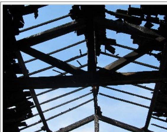
Figura 11 – Cobertura danificada pelo incêndio. Fotos de 21/06/2012
