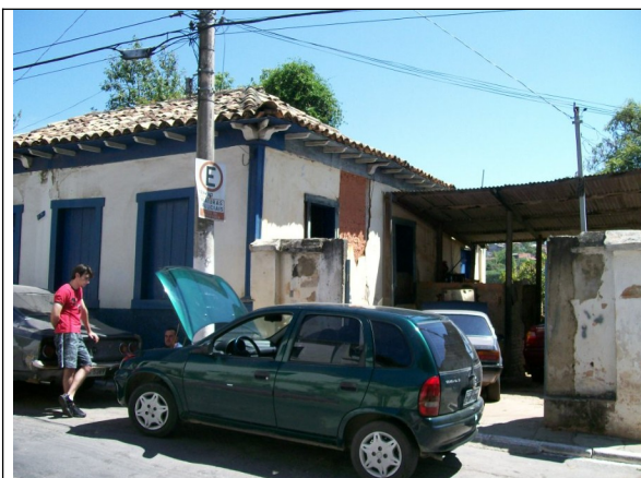
Figura 02 – Edificação tombada com funcionamento de oficina mecânica.
