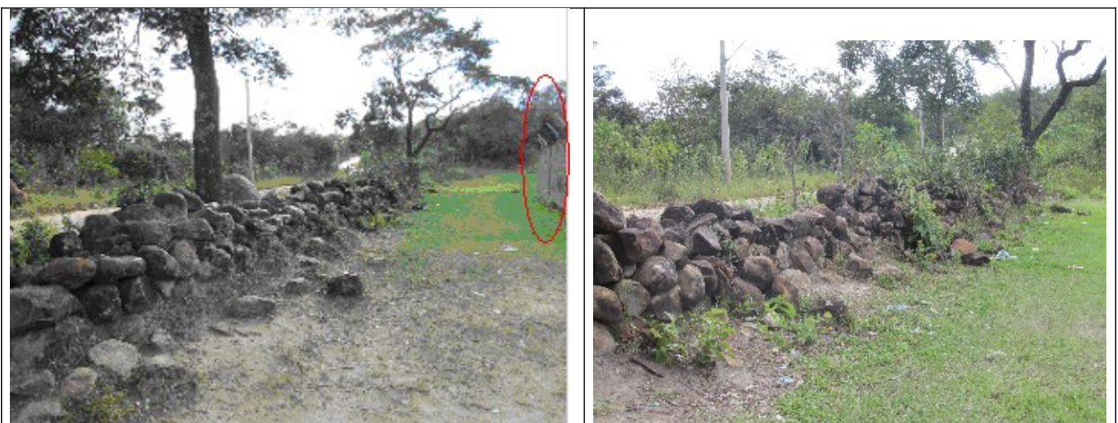
Figura 15 e 16- Muro de Pedras nas proximidades do campo de futebol (assinalado de vermelho na 1ª imagem). Foto da vistoria de 26/06/2012.
