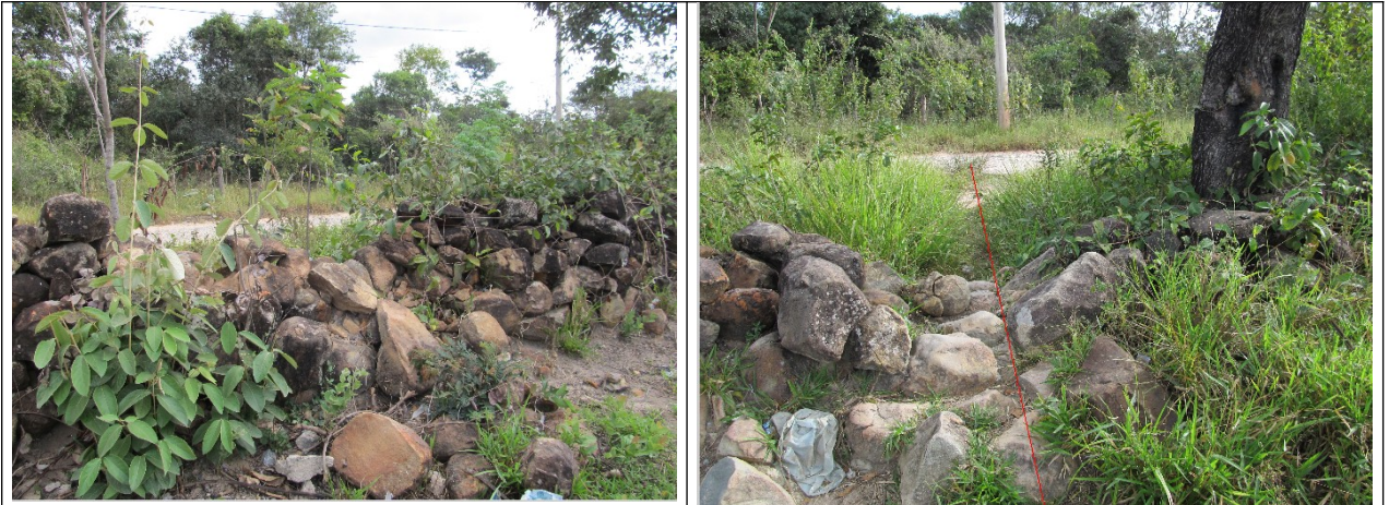
Figura 17 e 18- Muro de Pedras: vegetação, lixo e atalho formado nas proximidades do campo de futebol (assinalado de vermelho). Foto da vistoria de 26/06/2012.
