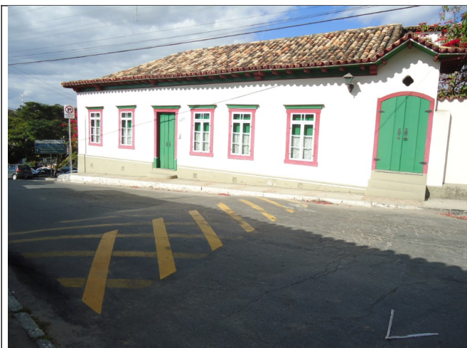
Figura 05 – Edificação com o quebra molas em frente, na via pública.
