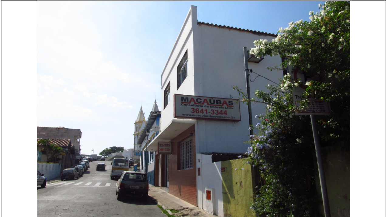
Figura 4- Edificação próxima à Igreja Matriz de Santa Luzia- Rua Direita. Nela se verifica a presença de engenho publicitário perpendicular à fachada, além de uma placa implantada em uma de suas laterais.
