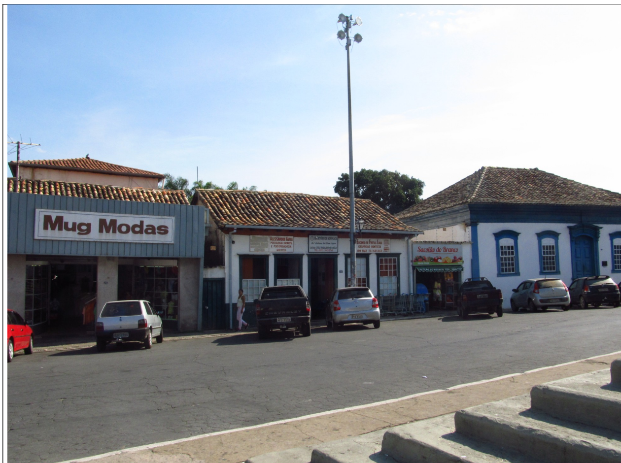
Figura 3- Edificações comerciais localizadas em frente à Igreja Matriz de Santa Luzia – Rua Direita. Nelas se verifica a presença de engenhos publicitários instalados nas fachadas.
