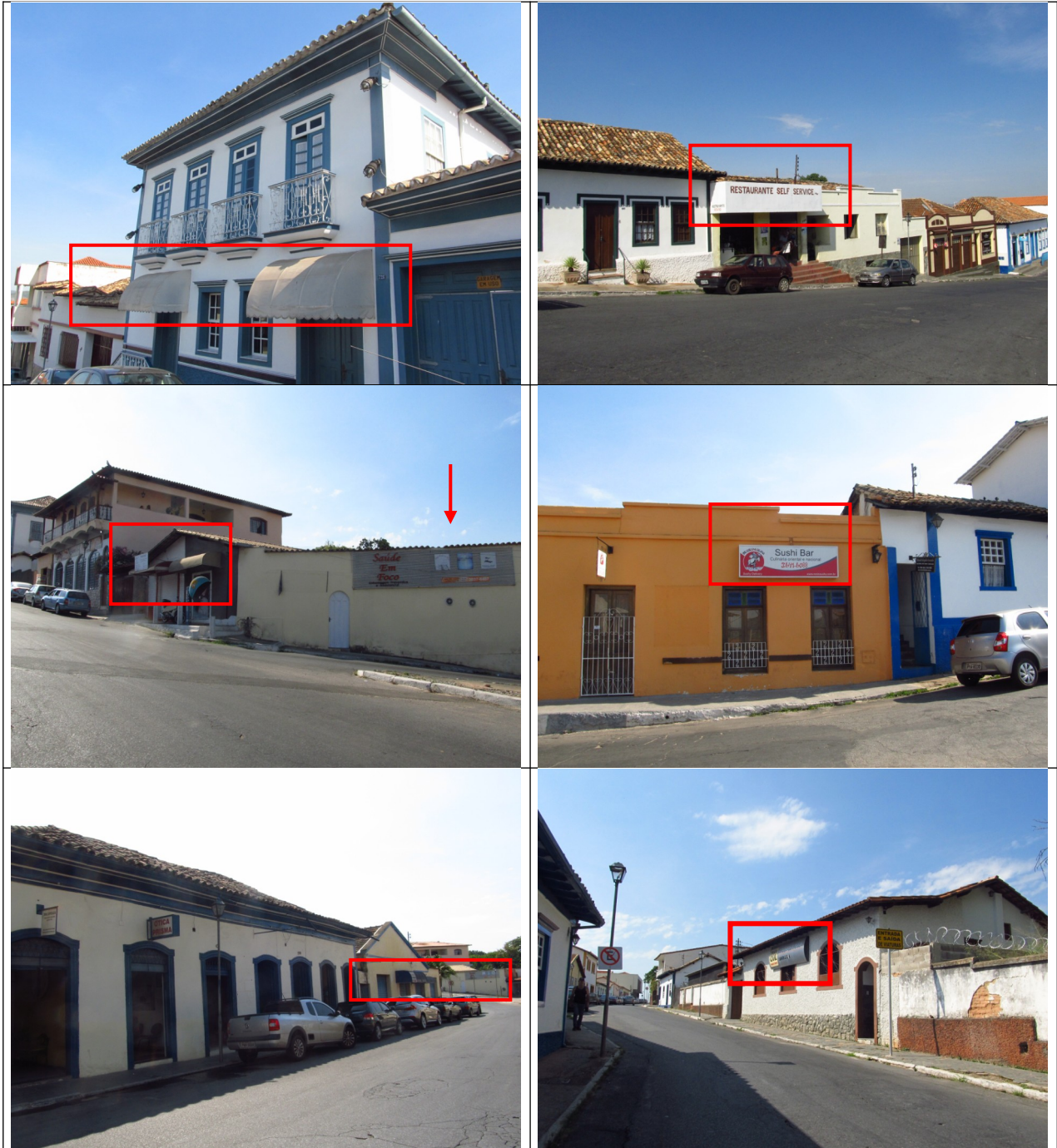
Figuras 6, 7, 8, 9, 10 e 11- Edificações na Rua Direita, com a presença de toldos e engenhos publicitários.
