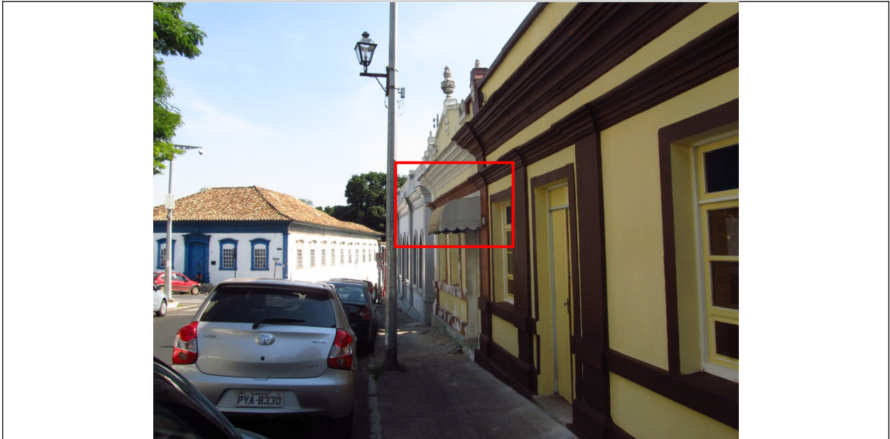
Figuras 19 e 20- Edificações com toldos e engenhos publicitários na Rua do Serro na lateral direita da Igreja Matriz.
