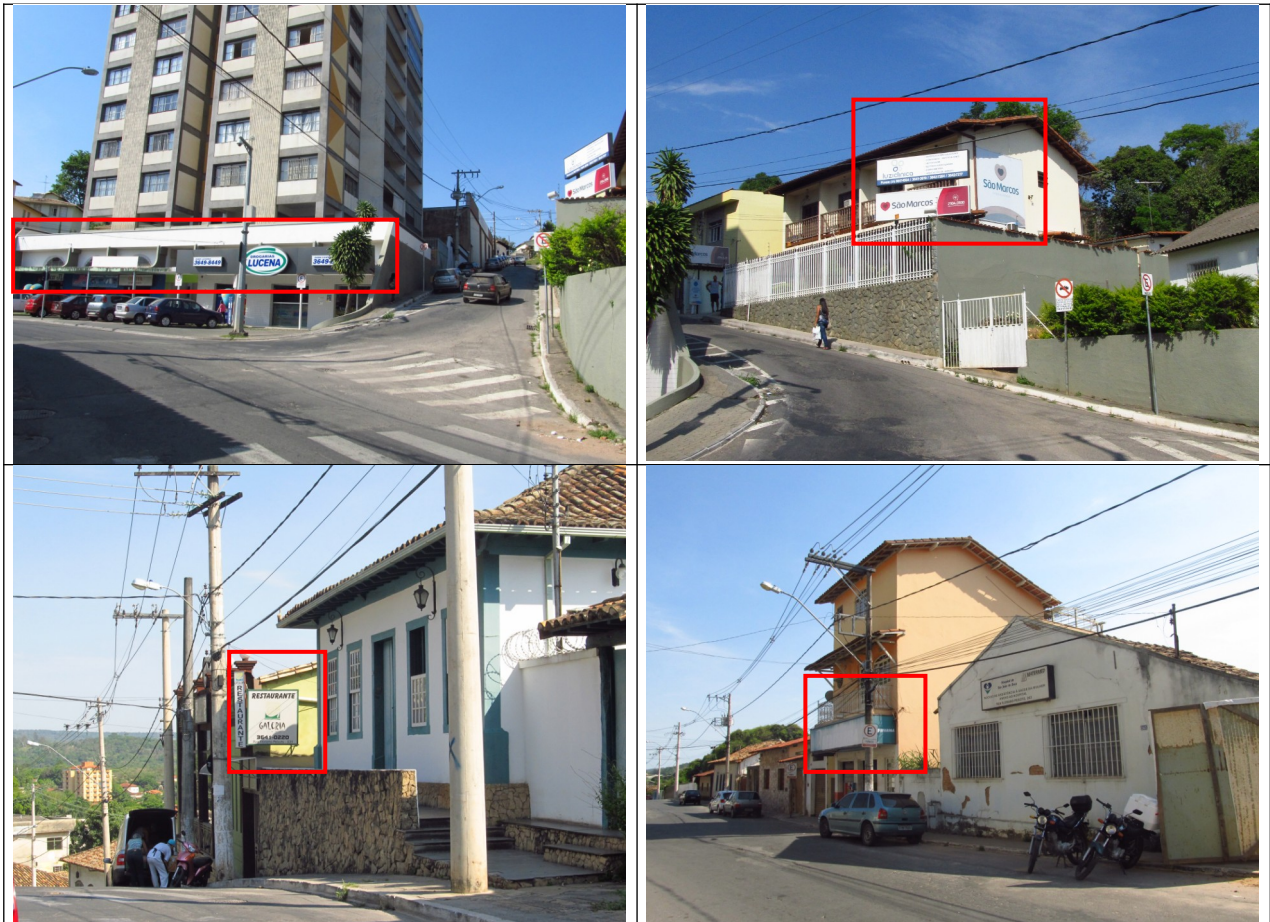
Figuras 13, 14, 15 e 16- Outras edificações com engenhos publicitários na Rua Floriano Peixoto. Na primeira imagem, o estabelecimento comercial notificado pela Prefeitura; na segunda, o engenho citado na Nota Técnica nº GAP 444/2015 elaborada pelo IEPHA.
