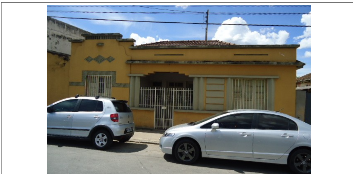
Figura 2 – Fachada frontal do imóvel da Rua do Comércio nº 86, Santa Luzia, anterior à intervenção. Fonte: Acervo da CPPC, 2014.
