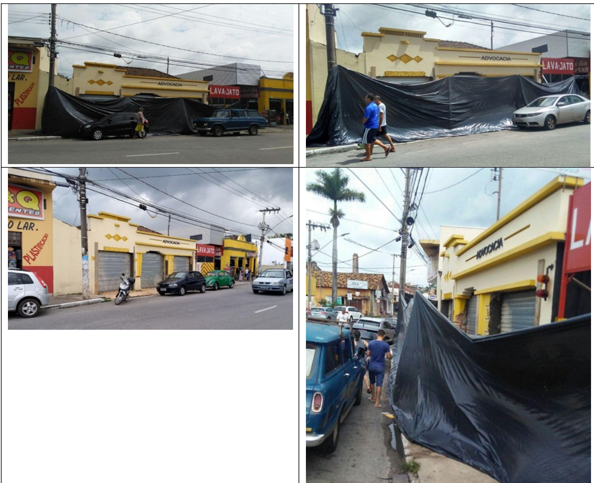
Figuras 3, 4, 5 e 6 – Imagens do imóvel da Rua do Comércio, nº 86, encaminhadas pela Associação Comunitária Cultural de Santa Luzia
