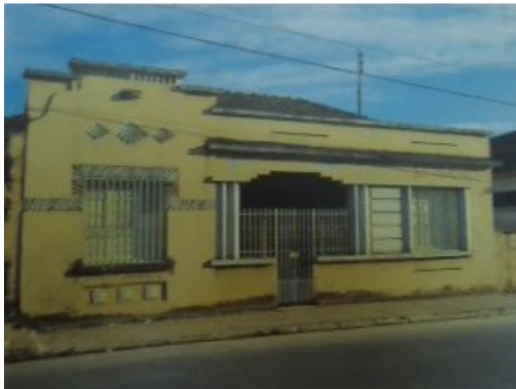
Figura 1- Edificação da Rua do Comércio, nº 86. Fonte: Ficha de Inventário do bem cultural, 2010.
