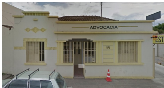
Figura 7 – Fachada do imóvel anterior a intervenção.
